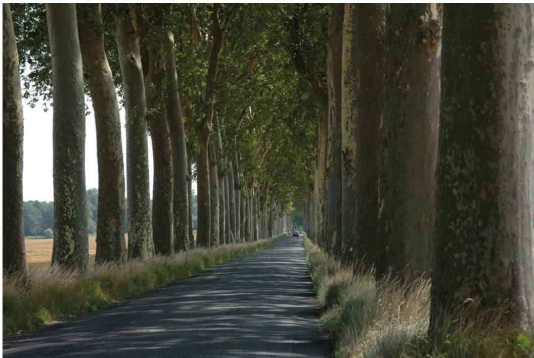
Figura 2. Tradicional alineació de plàtans de carrer millorant les condicions ambientals d'una carretera
