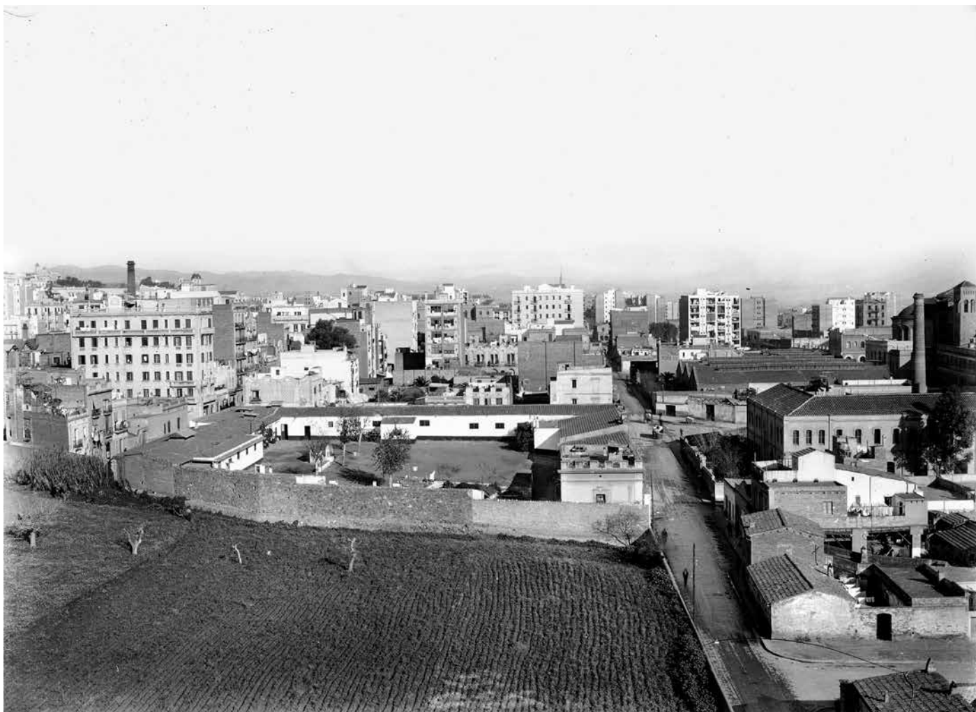
Imatge del recinte de l'antic escorxador de Gràcia, convertit en caserna de cavalleria de la Guàrdia Civil en el tercer terç de la dècada de 1920. JOSEP BARRILLON PARADELL / Fons NÚRIA BARRILLON PARADELL PI
