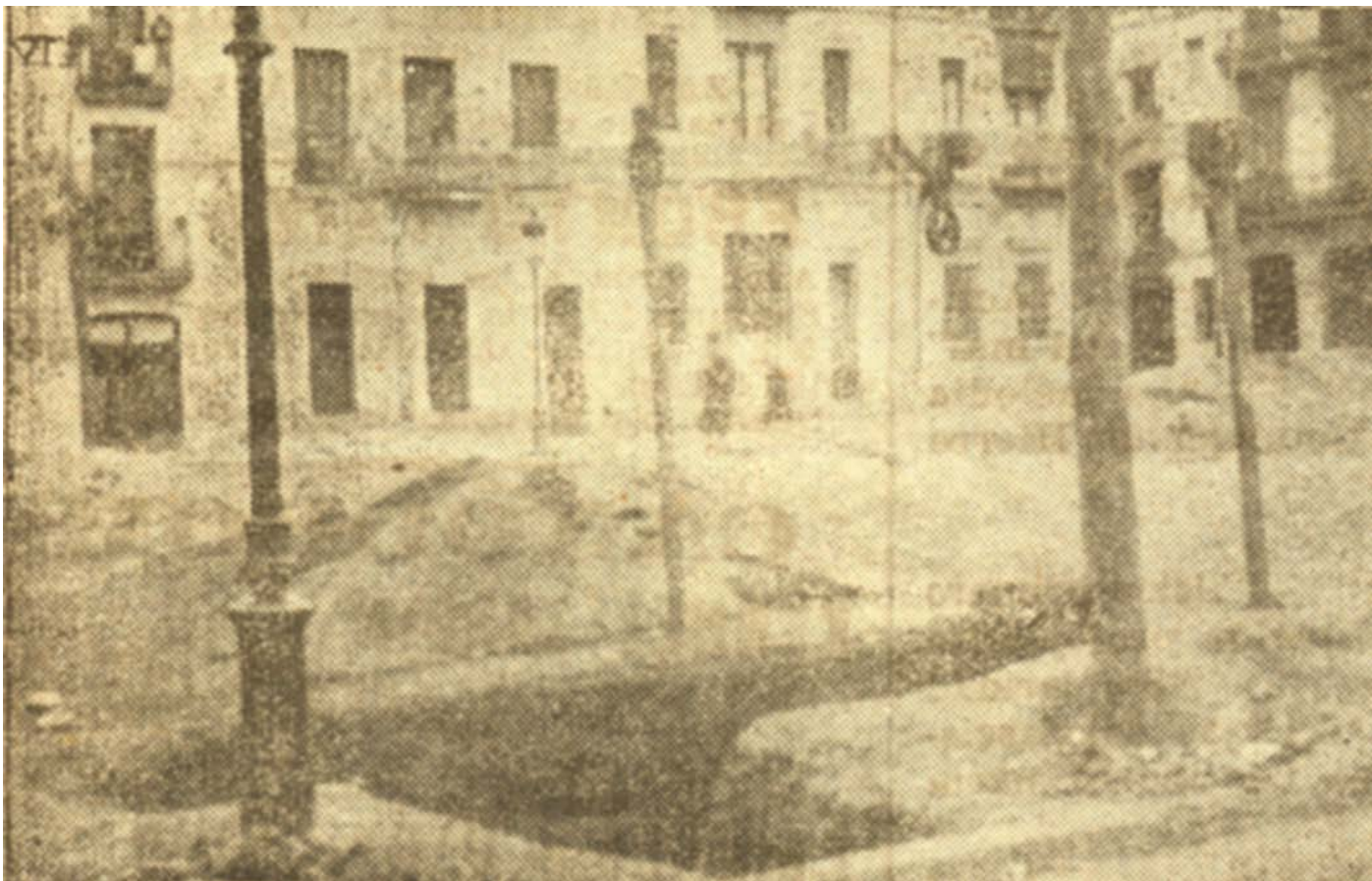
Fotografia de la construcció del refugi de la plaça del Diamant publicada al Diari de Barcelona Estat Català, del 8 d'abril de 1937. HEMEROTECA
