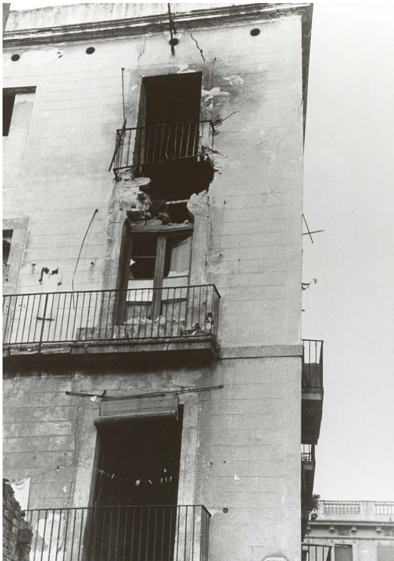
Aspecte que oferia l'edifici de la cantonada dels carrers del Perill amb Venus l'endemà del bombardeig naval del 13 de febrer de 1937. AFB
