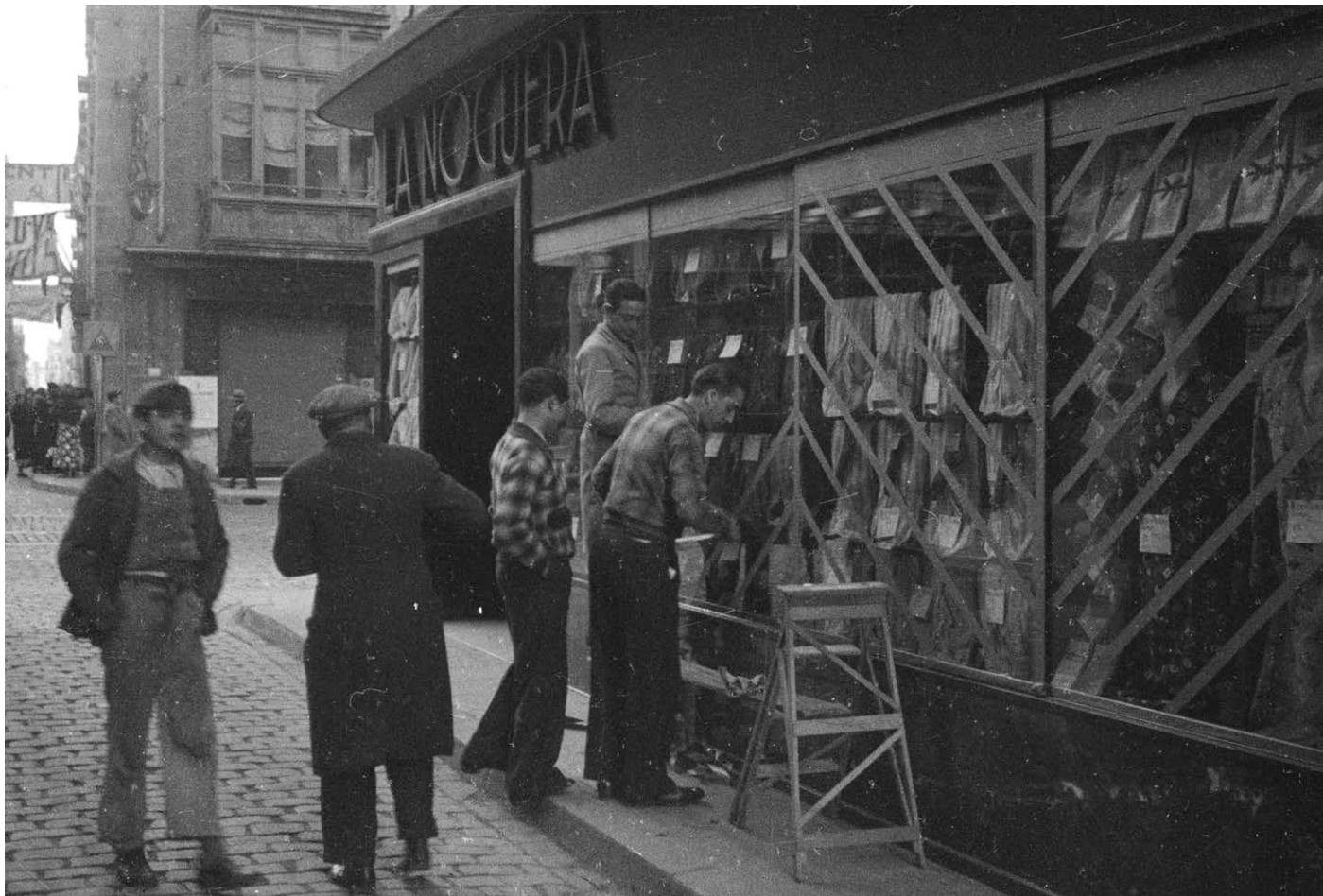
Empleats dels magatzems La Noguera, al carrer del Cigne cantonada amb Gran de Gràcia, protegint els vidres de les explosions dels bombardejos. JOSEP BARRILLON PARADELL/Fons NÚRIA BARRILLON PI
