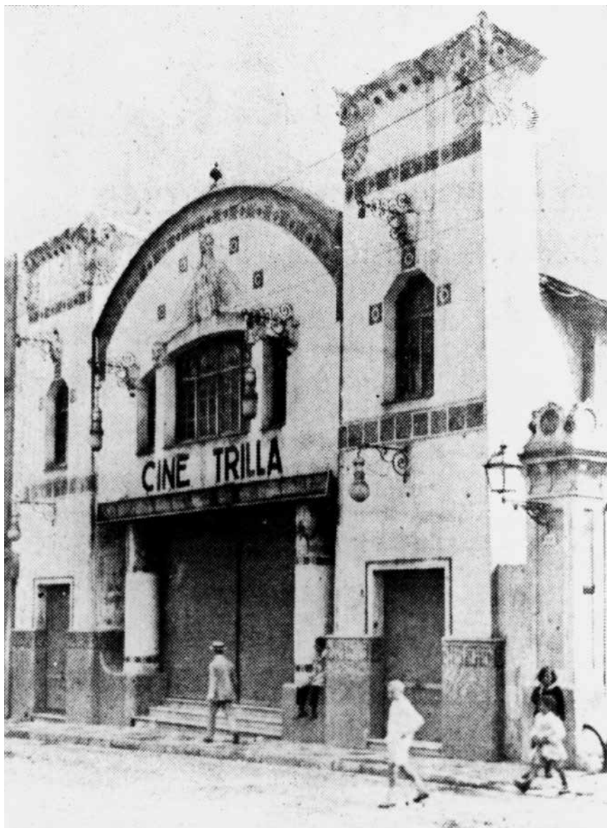
Façana del cinema Trilla al carrer Gran, entre el 1911 i 1920. AUTOR DESCONEGUT/ARXIU JMC
