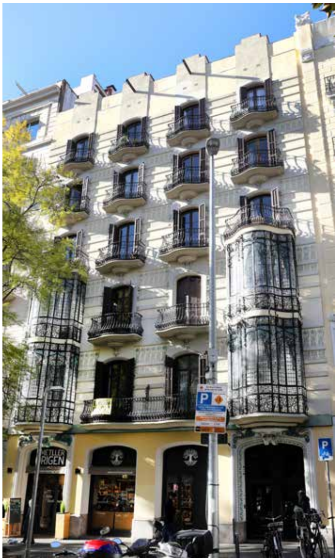
Façana de la Casa Cama i Ecurra al Pla de Salmerón, construïda per Francesc Berenguer i Mestres entre els anys 1902-1904. JOSEP MARIA CONTEL/ARXIU JMC
