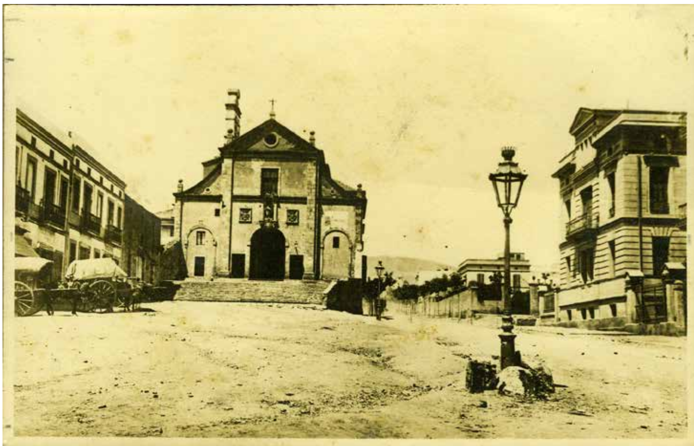
Imatge de l'església del Josepets i el seu entorn l'any 1870. AUTOR DESCONEGUT/AMDG Fons CEG
