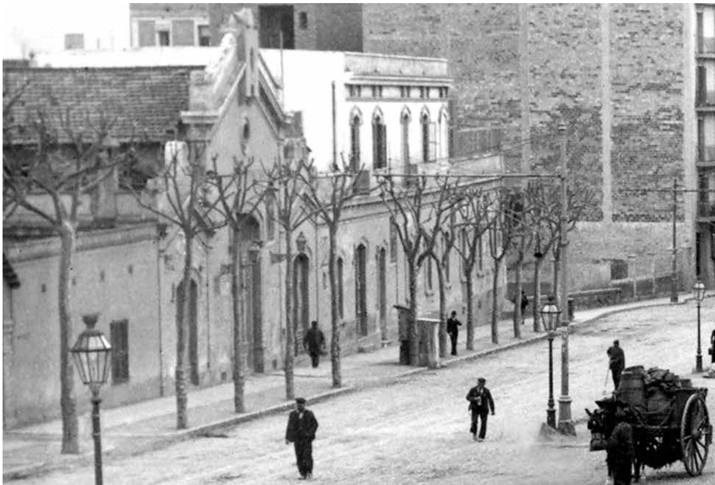
Edifici de la cotxera del tramvia de tracció de sang que es va construir a la plaça dels Josepets -plaça de Lesseps- amb una posterior remunta de color blanc. Tot seguit de la cotxera hi ha la barana de pedra sobre la riera de Vallcarca. AUTOR DESCONEGUT/AMDG Fons CEG
