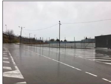
Fotografia emplaçament Marquesina
