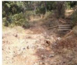
Aterrossament de talussos amb fustes.
