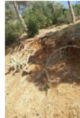
Casos d'erosió de talussos amb arrels d'arbres vistes.
