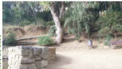
Talús deteriorat amb aterrossament de traveses de fusta.
