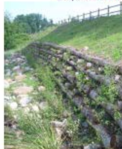
Exemples de murs d'entramat viu executats.
