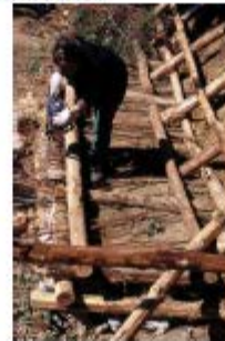
Exemples de murs d'entramat viu executats.
