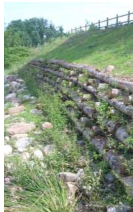
Exemples de murs d'entramat viu executats.
