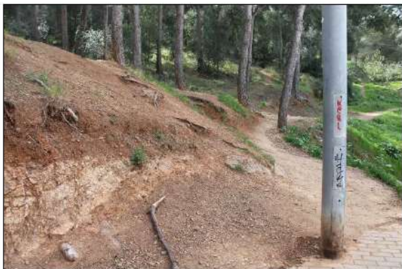
1 Talús a tractar amb mur de gabions
