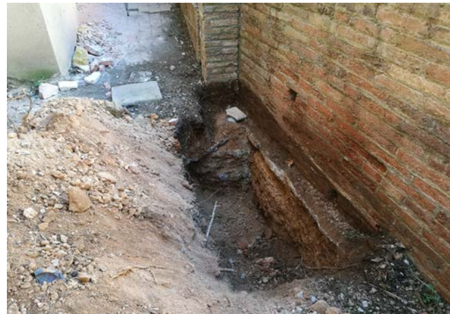
Cala als fonaments del mur de contenció de terres
