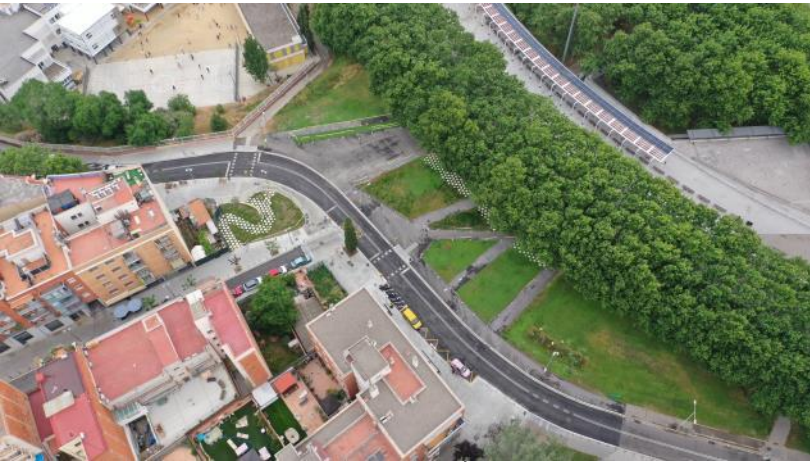
Vista est de les obres executades
