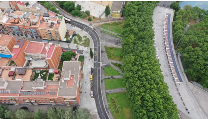
Vista Sud de les obres executades
