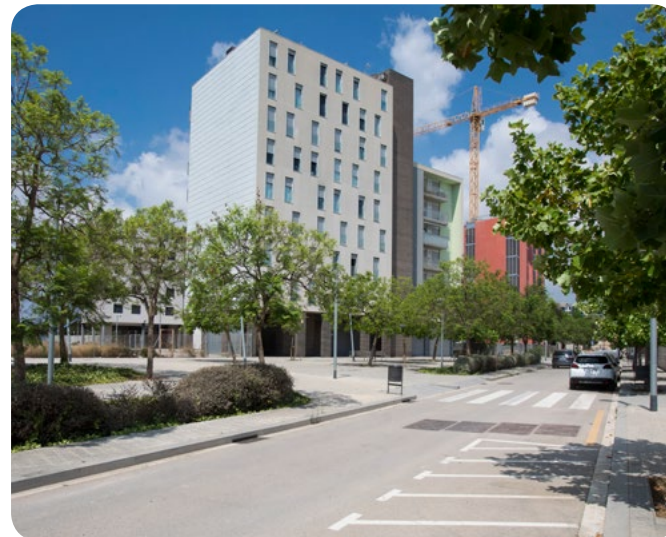
↑ Urbanització c. d'Ul·ldecona
