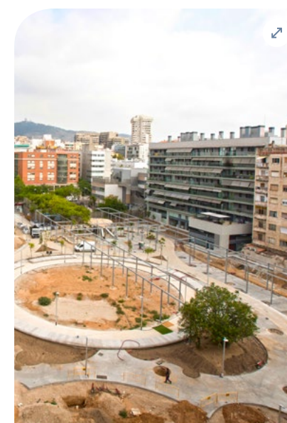
↑ Obres del nou parc de la Colònia Castells
