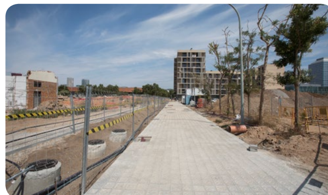
↑ Obres del Sector 3, c. del Ferro. Àmbit PEI
