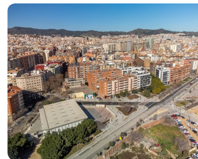
↑ Urbanització dels carrers del sector Entorns Sagrera
