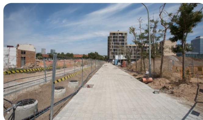
↑ Obras del Sector 3, c. del Hierro. Ámbito PEI
