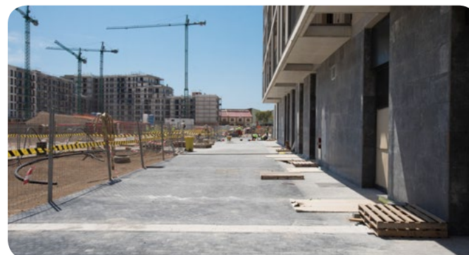
↑ Obras del Sector 3. Vías interiores y zonas verdes
