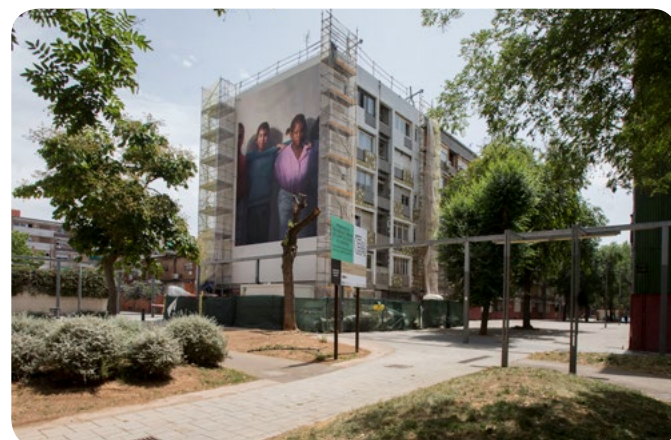
↑ Obras en la finca de la c. Messina, 11
