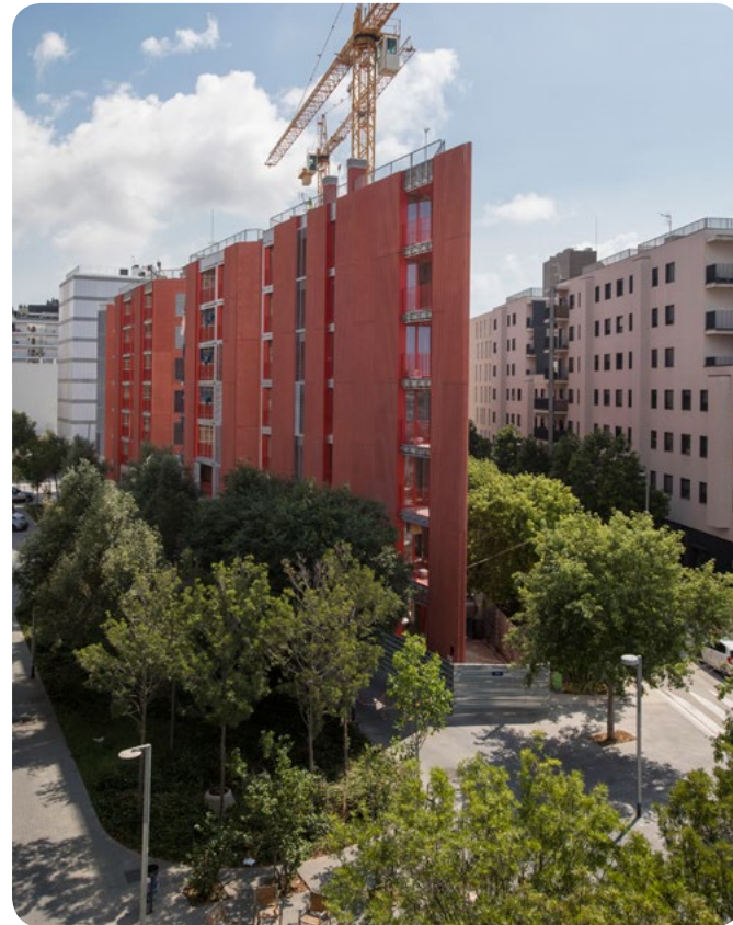
↑ Urbanización cruce c. de Ulldecona con Cal Cisó
