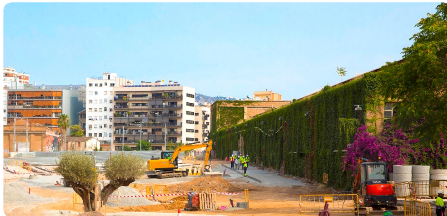
↑ Obras de la Zona Verde Can Batlló
