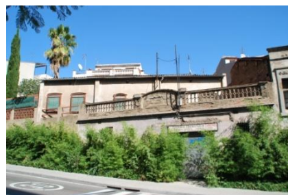
Carretera de Ribes 104-102. Part posterior a Carrer Mireia 11.
