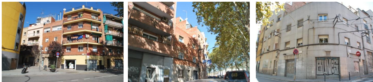
Façanes a Via Bàrcino entre Ausona i Vicenç Montal
