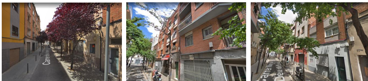
Façanes carrer Ausona i carrer Mare de Déu de Lorda
