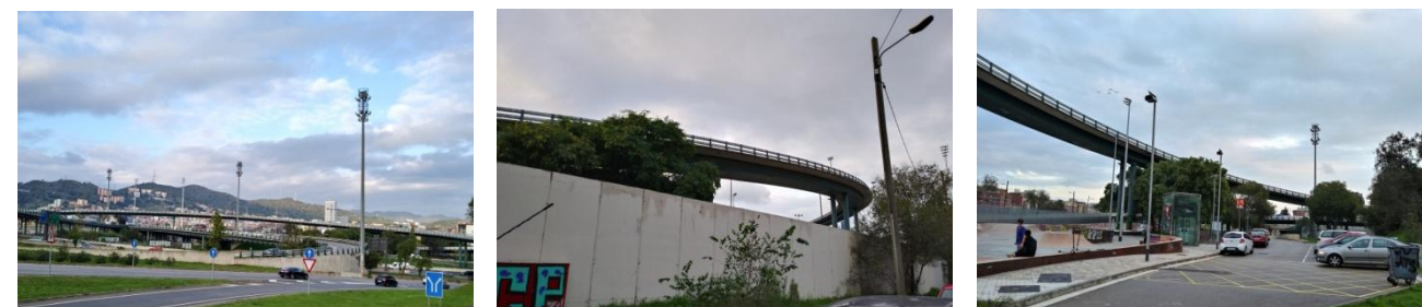
El Nus de la Trinitat, una infraestructura que no s'atura.
