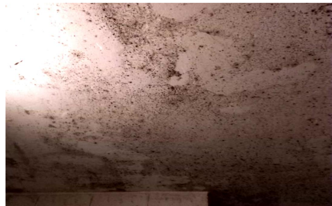
Fig. 4.3-21: Fotografia d'humitats de condensació en un bloc dins de l'àmbit
