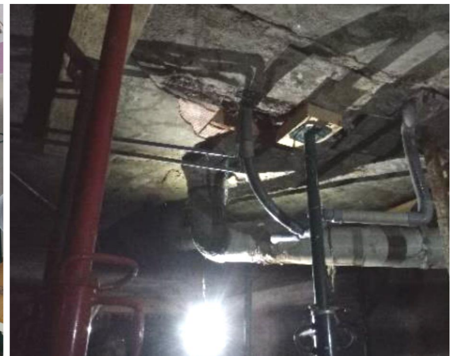
Fig. 5.4-3: Apuntament de càmera sanitària
