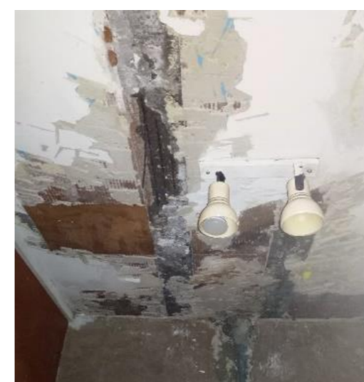
Fig. 4.3-8: Imatge de possible afectació per aluminosi
