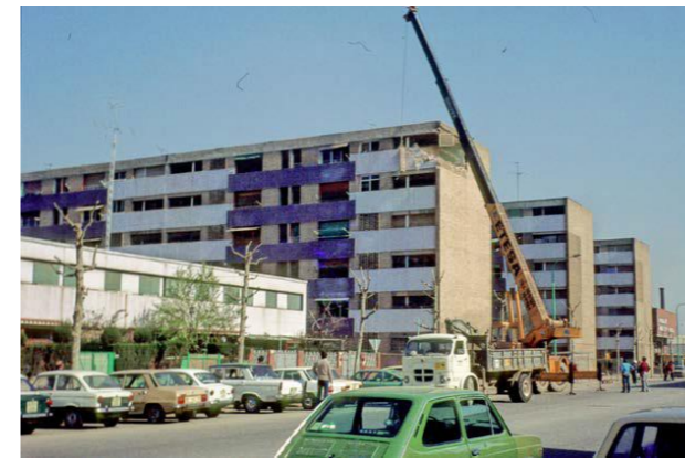
Fig. 5.1-1: Inici de l'enderroc d'un bloc de tipologia M
