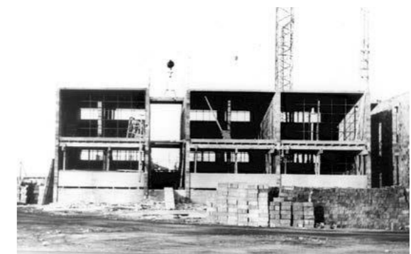
Fig. 4.2-7: Imatge de la construcció de murs
