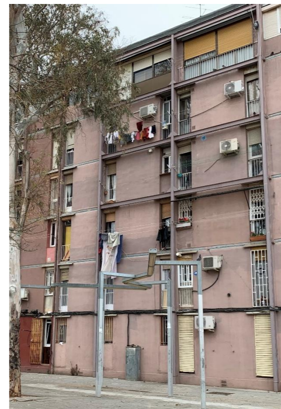
Fig. 5.3-2: Reforç estructural a la façana de bloc de tipologia J
