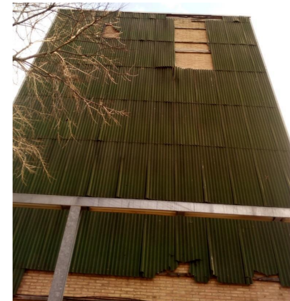
Fig. 5.3-8: Estat actual dels envans pluvials
