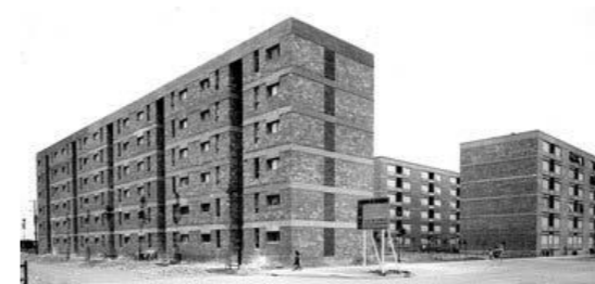
Fig. 5.3-9: Acabat original de façana d'obra vista
