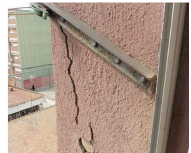
Fig. 4.3-12: Esquerda en un brancal (ITE)
