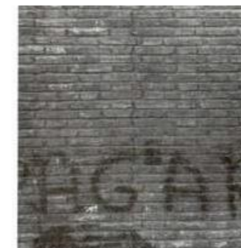
Fig. 4.3-11: Esquerda a un mur (E. patològic)
