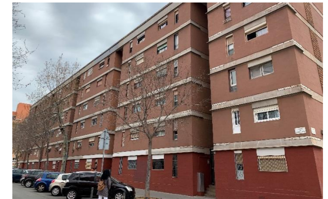
Fig. 5.1-4: Bloc rehabilitat de la tipologia L
