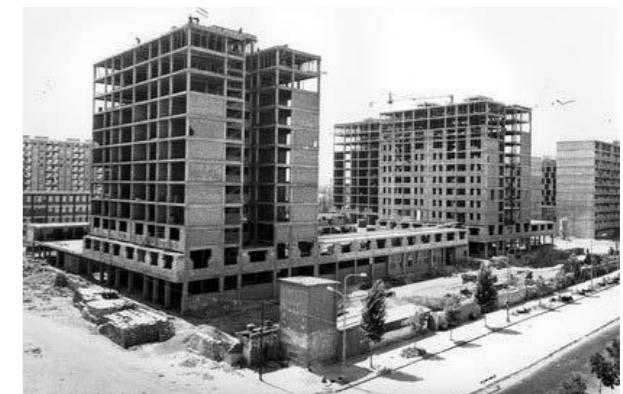
Fig. 4.2-8: Imatge de la construcció de pòrtics
