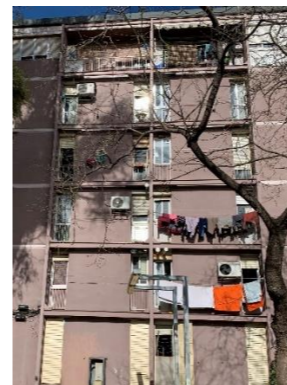
Fig. 4.3-3: Indicis d'insuficiència de trava lateral
