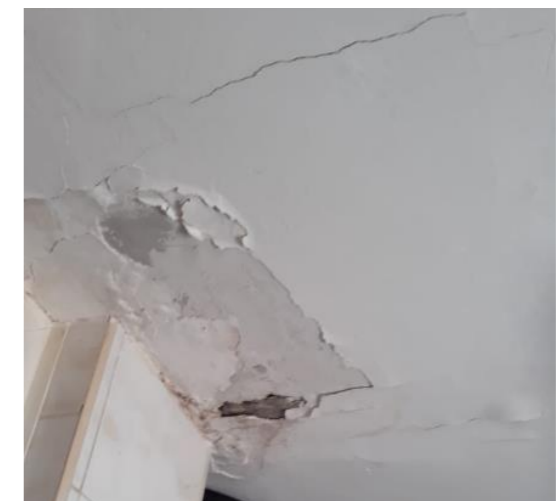
Fig. 4.3-28: Humitats al voltant dels baixants
