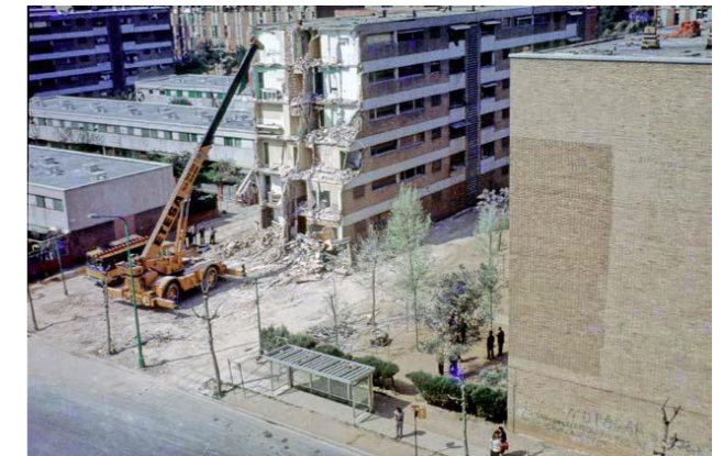
Fig. 5.1-2: Enderroc d'un bloc de tipologia M
