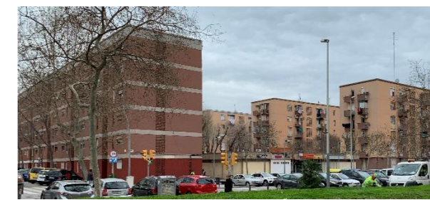
Fig. 5.3-10: Aspecte de la rehabilitació de façanes
