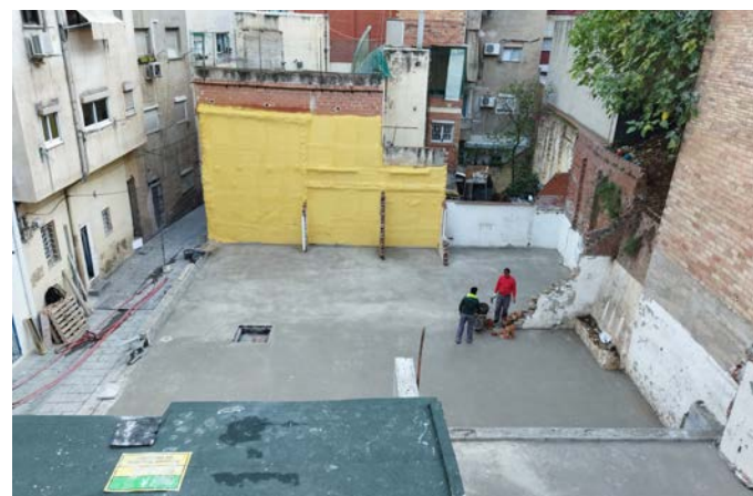
▲ Obres de desconstrucció al c. de Sigüenza
