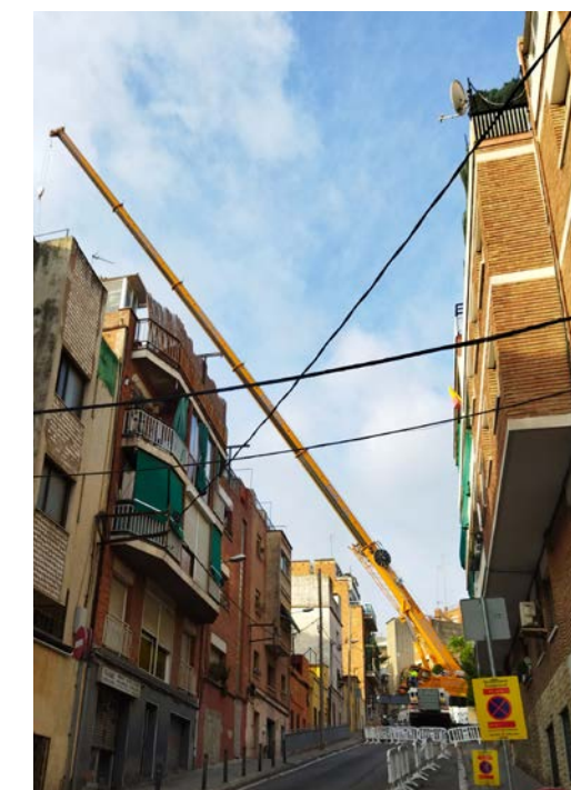
▲ Obres de desconstrucció al c. de Sigüenza
