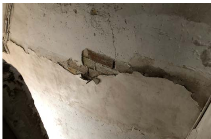
▲ Estat abans de l'intervenció de l'IMU
