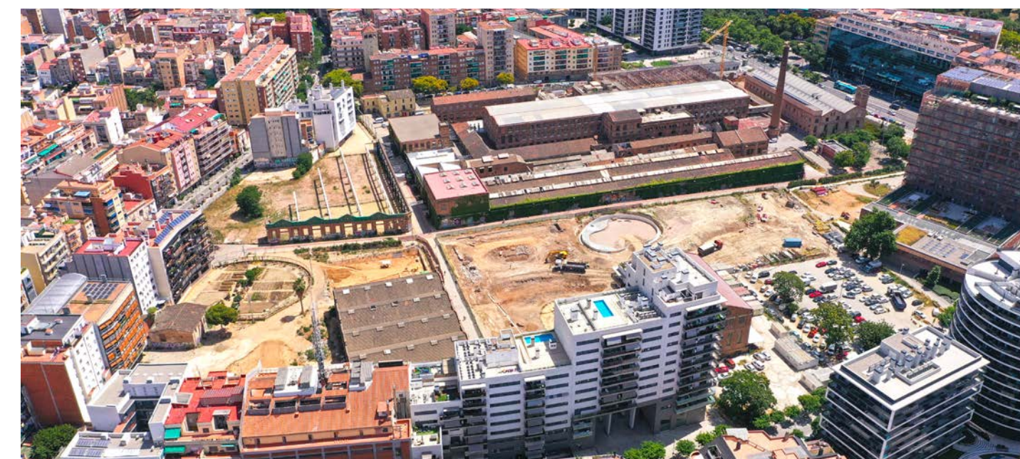
▲ Obres d'urbanització Zona Verda
