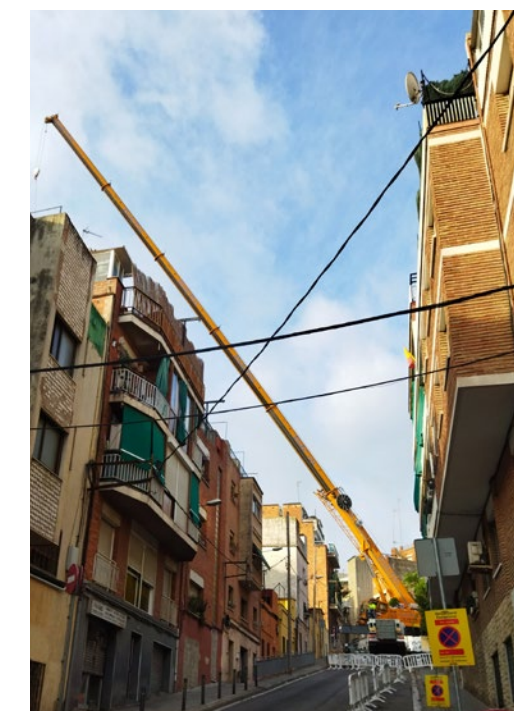
Obras de desconstrucción en la c. de Sigüenza
