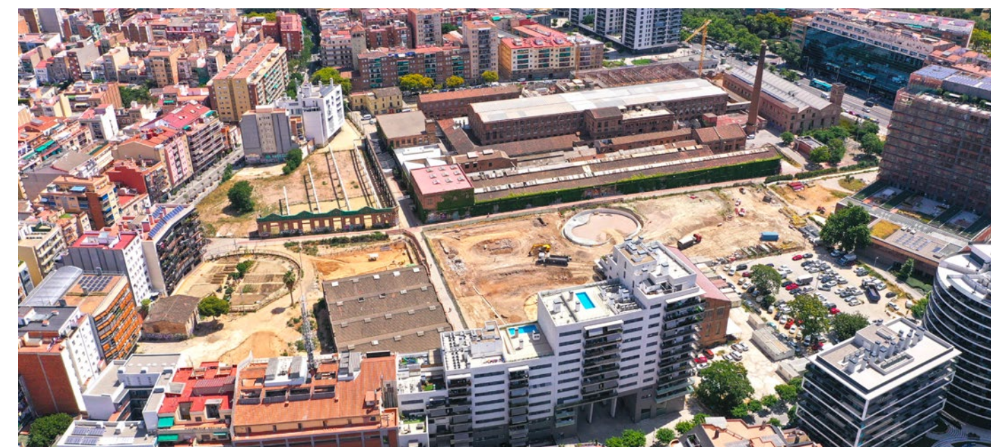
▲ Obras de urbanización Zona Verde
