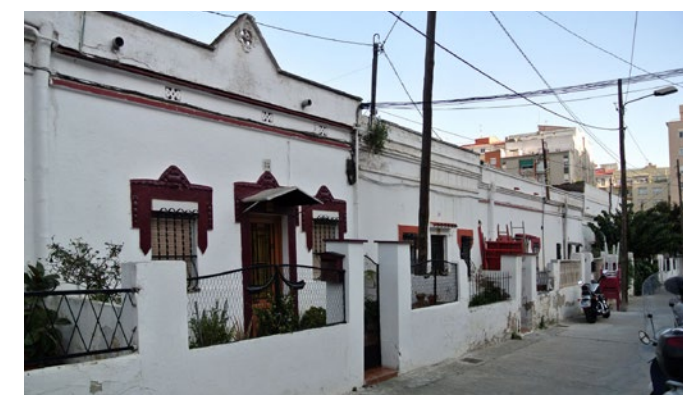
▼ Casetas en la Colònia Castells
