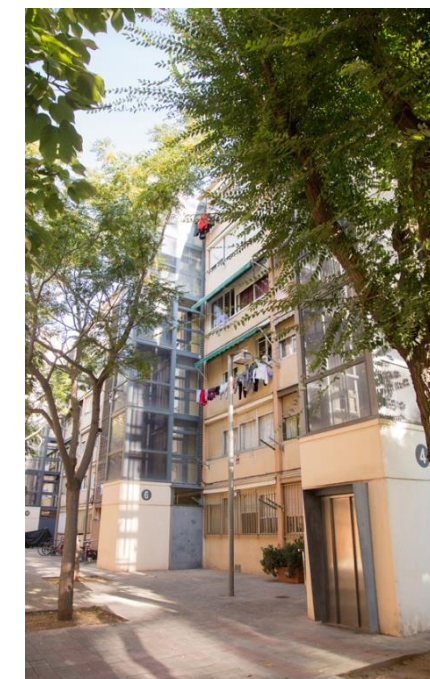
2 Vista volum ascensor de Prada 4 -6
