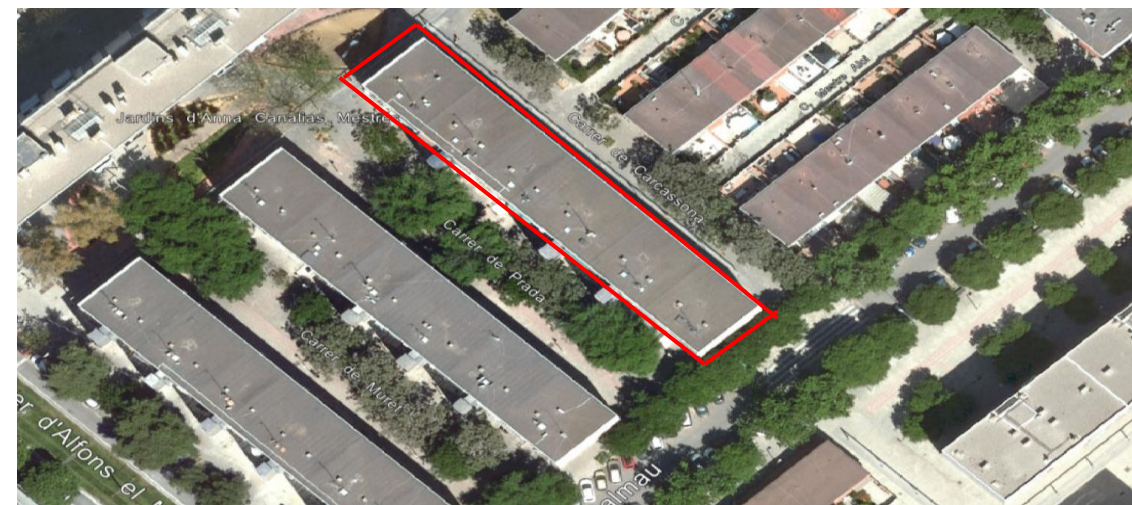
Situació de la finca ubicada al carrer Prada 2-12
