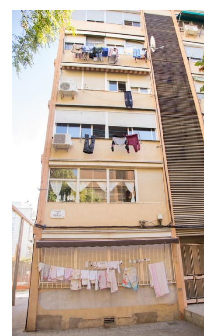
3 Vista façana de Prada 2
