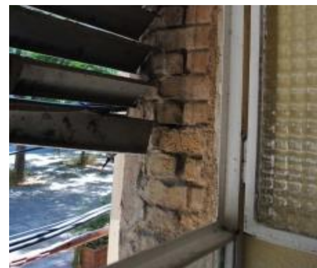
Fusteria de l'escala junt amb el tancament de lames a façana
