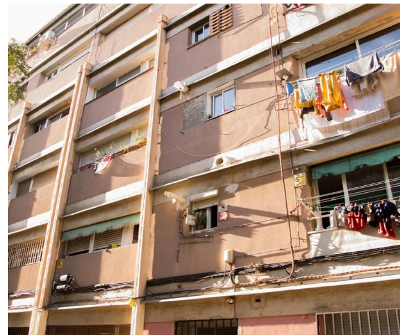
3 Vista façana c. Teulada
