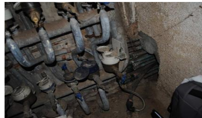
Tubs comptadors de plom, no han estat substituïts encara
