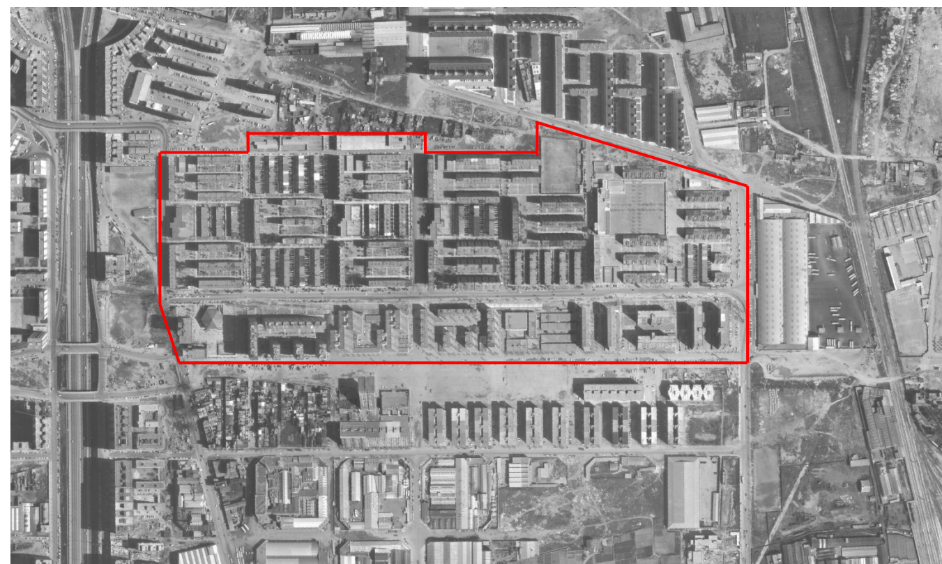
Vista aèria del 1974 de l'àmbit de l'Àrea de Regeneració Urbana
