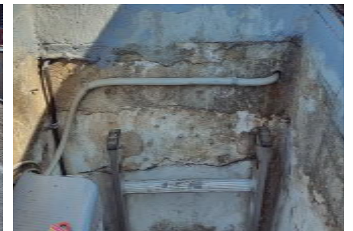
Reparació de les juntes de la làmina impermeable
