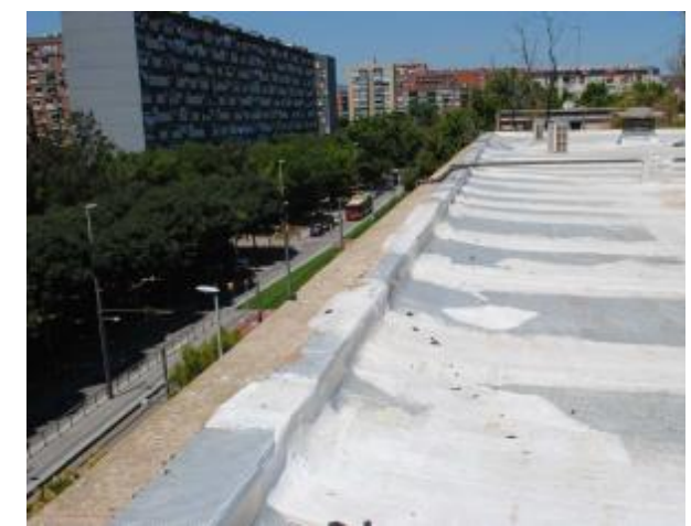
Reparació de les juntes de la lamina impermeable
