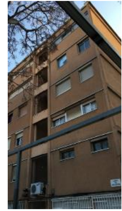
vista de consoles a façana
