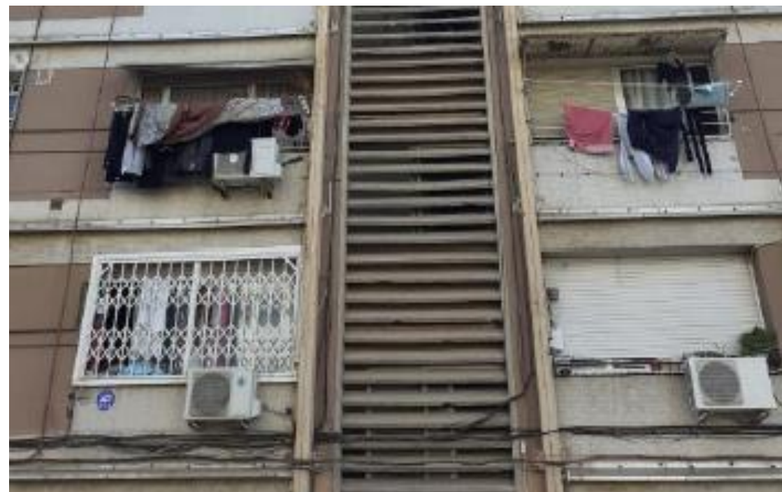
Passos d'instal·lacions i aparell de ventilació a façana del c. Caller
