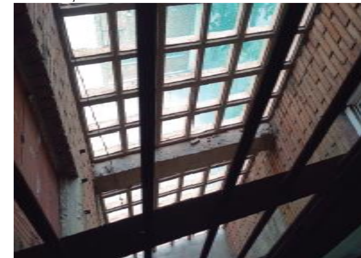
Vista interior del pati de façana Rodés
