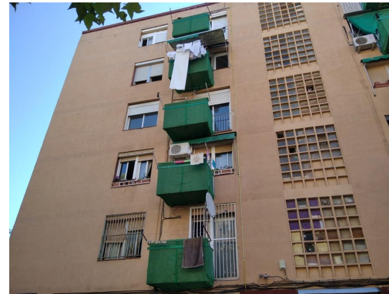
Xarxa de protecció en els balcons i tancament del nucli d'escalles a façana del c. Benevent
