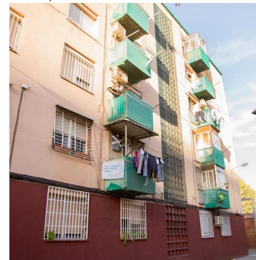
Xarxa de protecció a façana del c. Rodés
