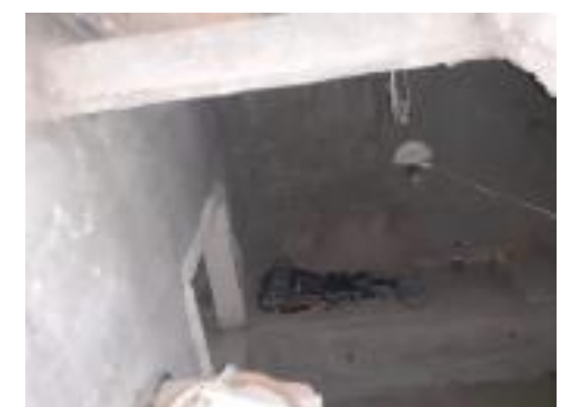
Accés a la cambra sanitària
