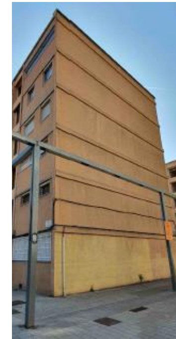
Vista dels cantells dels forjats al tester
