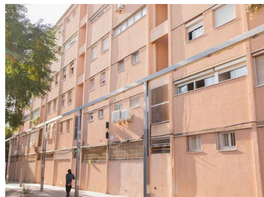
4 Vista de la façana de l c. Carcassona amb les obertures a patí
