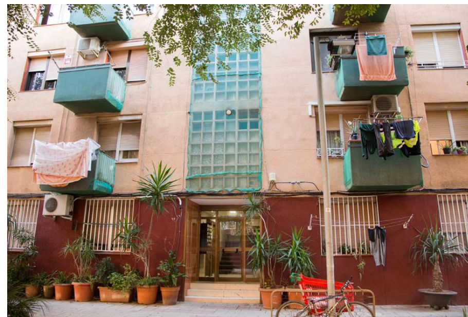
Xarxa de protecció en els balcons i tancament del nucli d'escales a façana del c. Tessàlia
