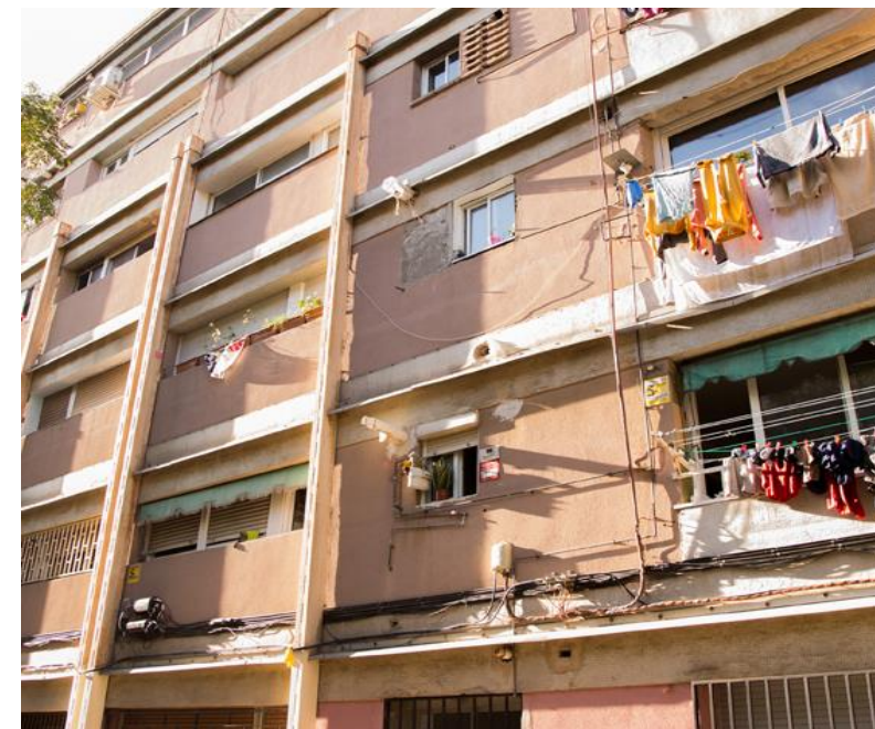
3 Vista façana c. Teulada
