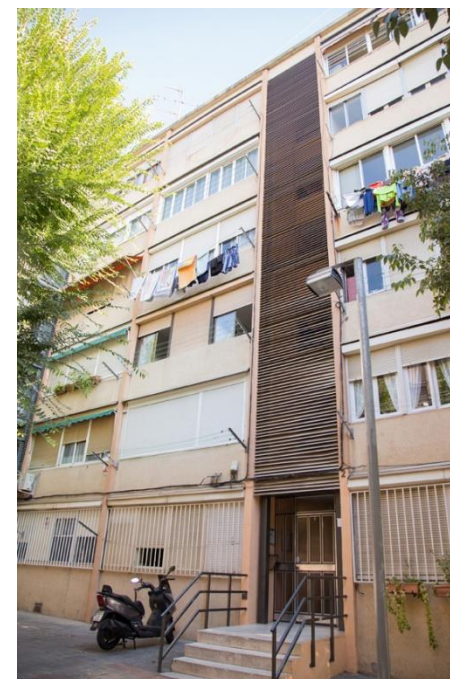
1 Vista façana de Prada 12
