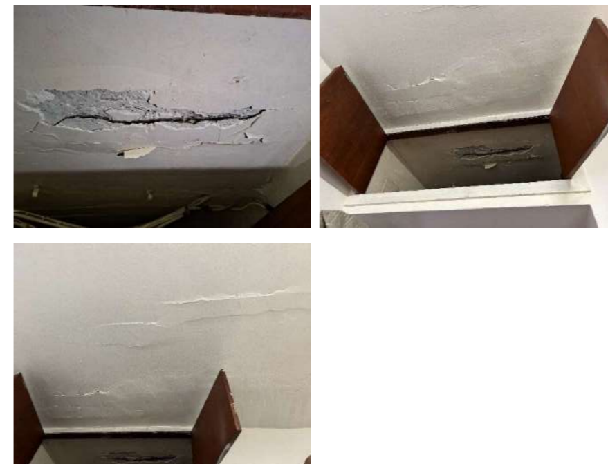
Detalls passadís bany a l'habitació de carrer
