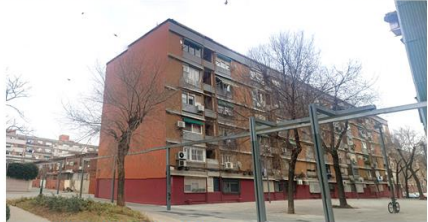
- FOTOGRAFIA FAÇANA CARRER TRAPANI ESTAT ACTUAL
