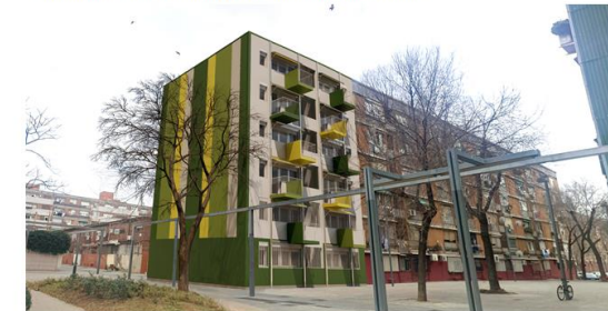
- FOTOGRAFIA FAÇANA CARRER TRAPANI PROJECTE
