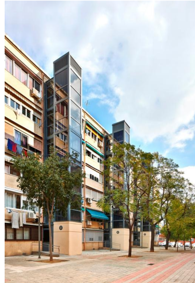
IMATGE DEL CARRER MURET, 4-6-8 ANY 2012
