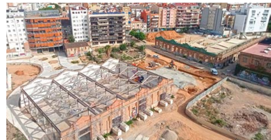
Obres d'urbanització de la zona verda de Can Batlló
