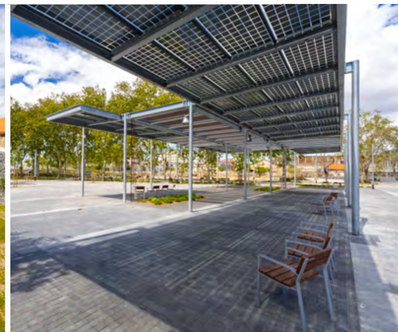
Pèrgola amb plaques fotovoltaïques al Parc
