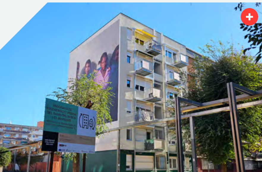
Obra c. de Messina, 11
