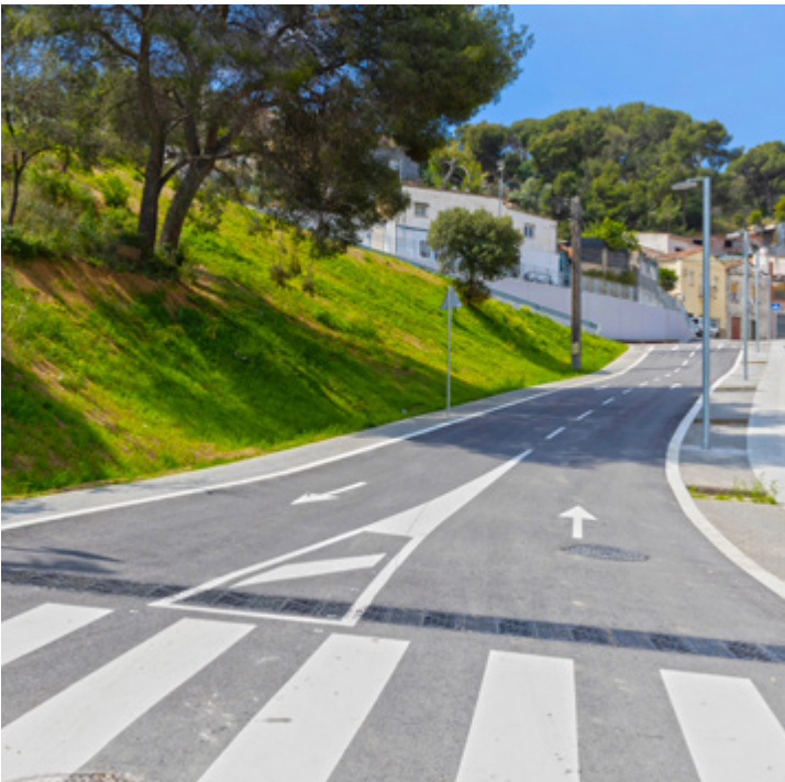
Urbanització PAU 2 Torre Baró
