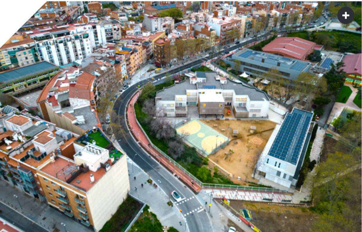
Urbanització via Bàrcino. Fase A', cua del viari
