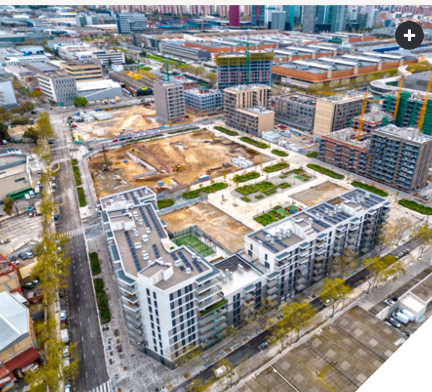
Urbanització del Sector 3
