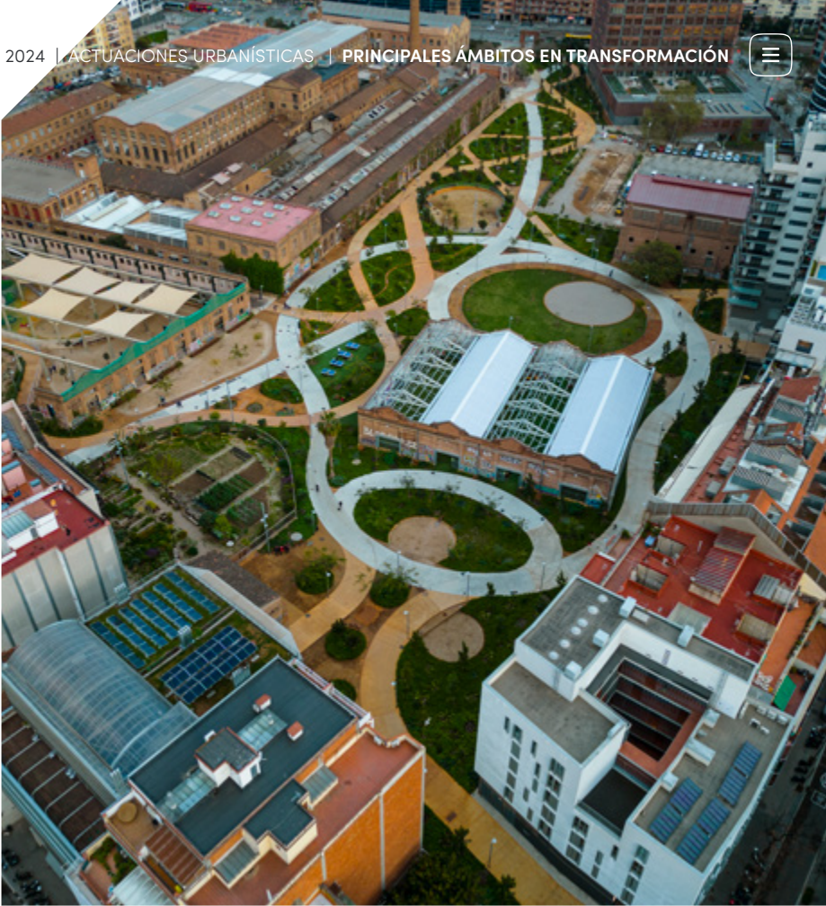
Vista aérea de la urbanización
