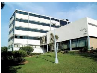
Edifici de la Facultat de Dret (UB)
