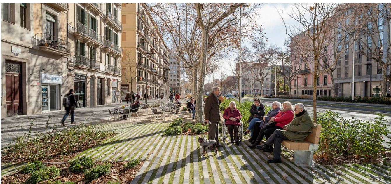
Referent de pavimentació filtrant. Passeig de Sant Joan de Barcelona
