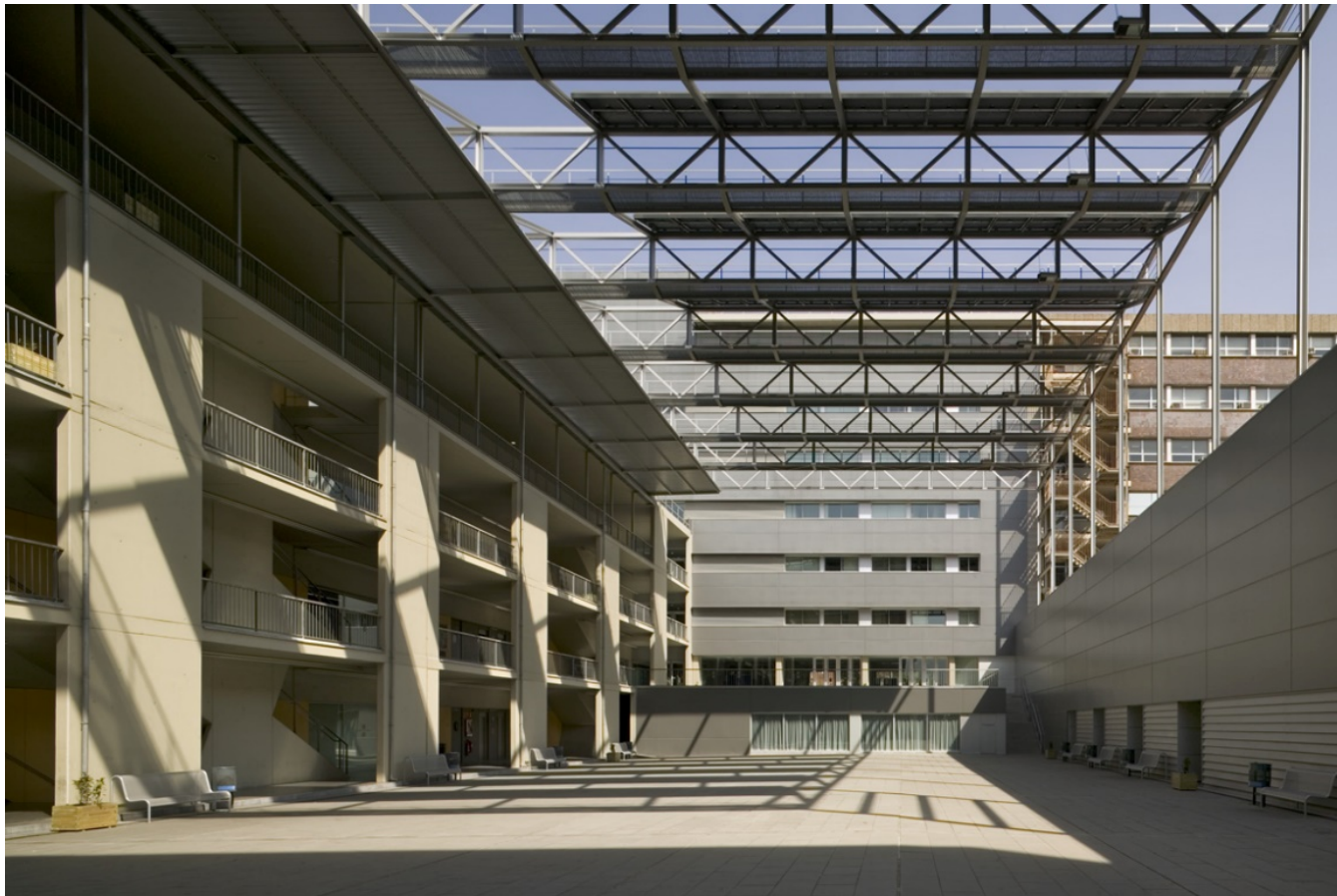
Autoproducció energètica urbana. Vista de l'Atri Solar a les Facultats de Física i Química de la UB amb plaques fotovoltaïques
