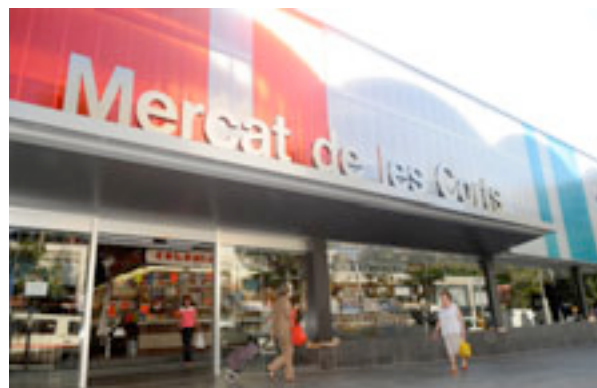
Nou Mercat de Les Corts, remodelat l'any 2008
