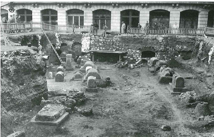
Moment de l'excavació dels anys 50 Foto: MHCB
