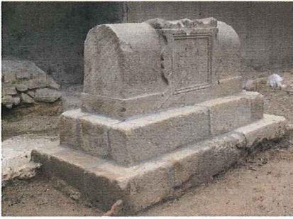
Reintegració amb morter de les juntes entre pedres Foto: Pere Vivas
