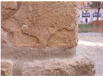
Laminació de la pedra de la cupa núm. 2 Foto: MHCB
