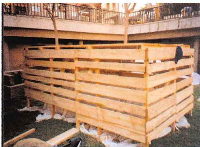
2] Treballs d'enderroc de la pantalla de formigó Foto: MHCB
