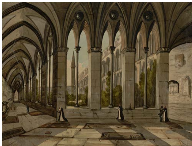
↑ Vista del claustre del convent de Santa Caterina. M. Redón, 1800-1844. AHCB
