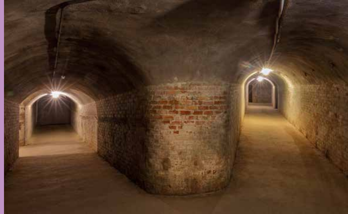
Galeries de l'interior del refugi. © MUHBA / Manuel Cohen
