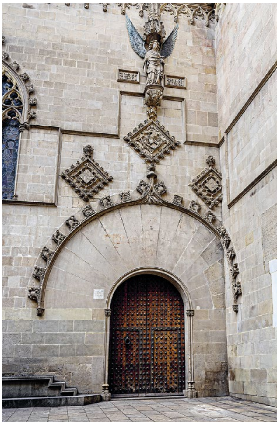
Portada de la Casa de la Ciutat, obra de Jordi Joan, 1400, amb l'extrem doblegat per adaptar-se a la reforma de l'edifici el 1840. Fotografia d'Stanislav Biel Lorente. MUHBA
