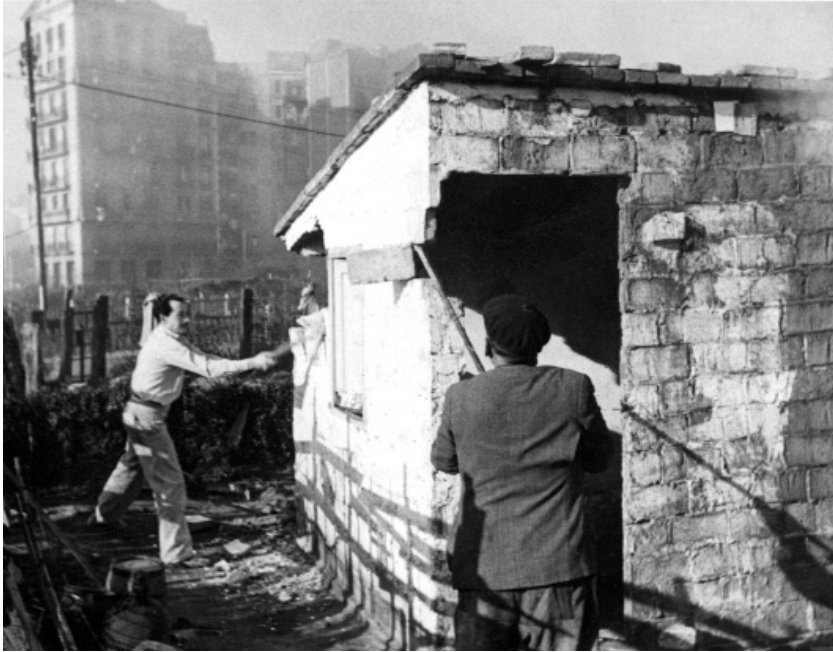
Treballadors del Servei de Control i Eradicació del Barraquisme enderroquen un assentament, 1953
