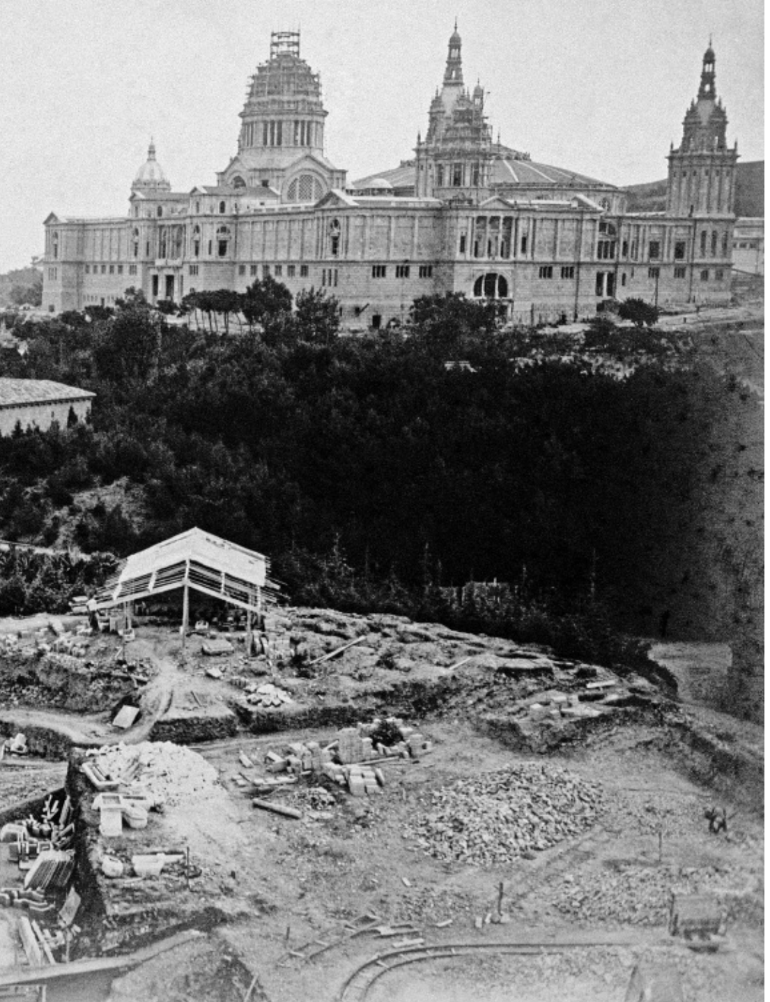
El Poble Espanyol en construcció, 1929
