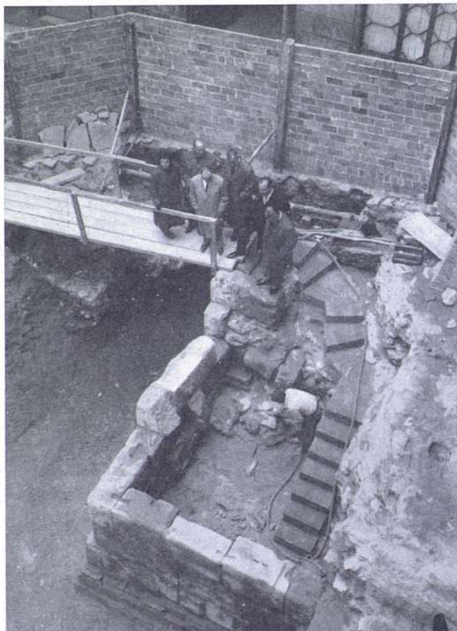
Interior de la torre 26, el 19 de diciembre de 1959, al ser puestas a la luz las testas marmóreas allí descubiertas incorporadas al mortero. (La escalera que desciende a él fue construida a los fines de la excavación y es, por lo tanto, moderna.) Obsérvense los encajes para las uniones de los sillares.
