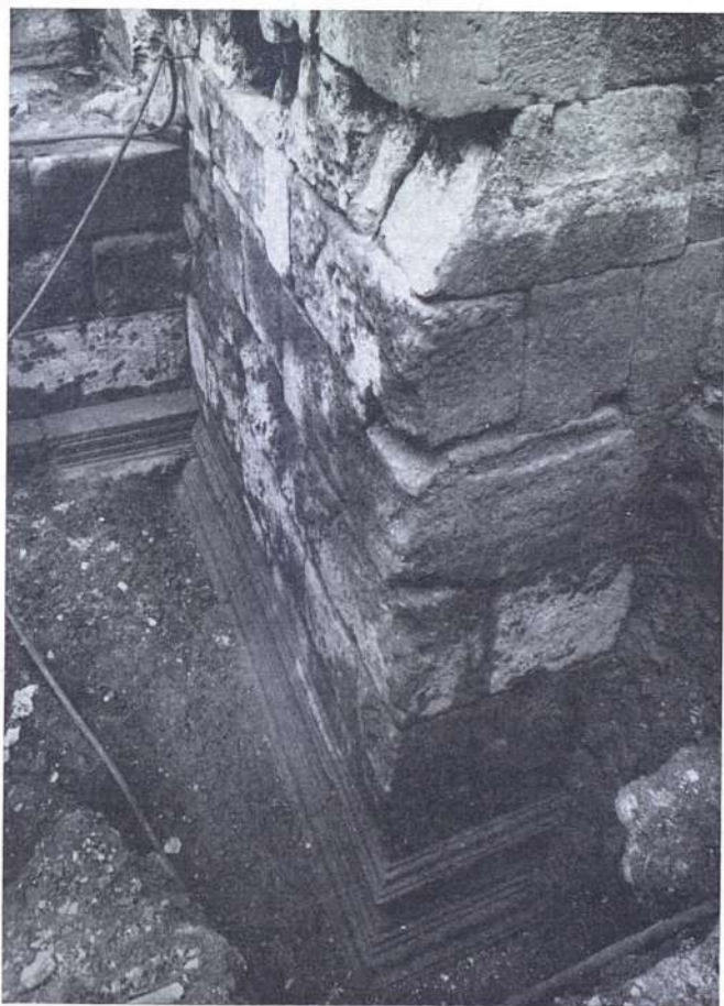
Angulo sudeste de la torre 25, en el «carrer de Basea», tal como apareció al ser puesto a la luz el día 21 de noviembre de 1959. Posteriormente la cornisa invertida que forma su basamento ha sufrido algún lamentable deterioro.
