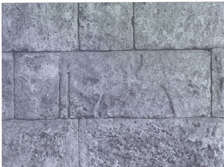
Lienzo entre las torres 24 y 25, en el «carrer de Basea», con un gran sillar que debió formar parte de un monumento funerario, del que se han descubierto otros elementos en el mismo sector de muralla. Mide 1,35 metros de longitud.
