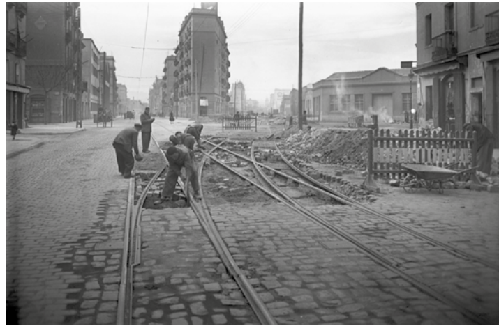
Treballs de connexió de les línies dels tramvies que recorrien els carrers de Pere IV i Pallars, 1930. Foto: Josep Brangulí. Arxiu Nacional de Catalunya
