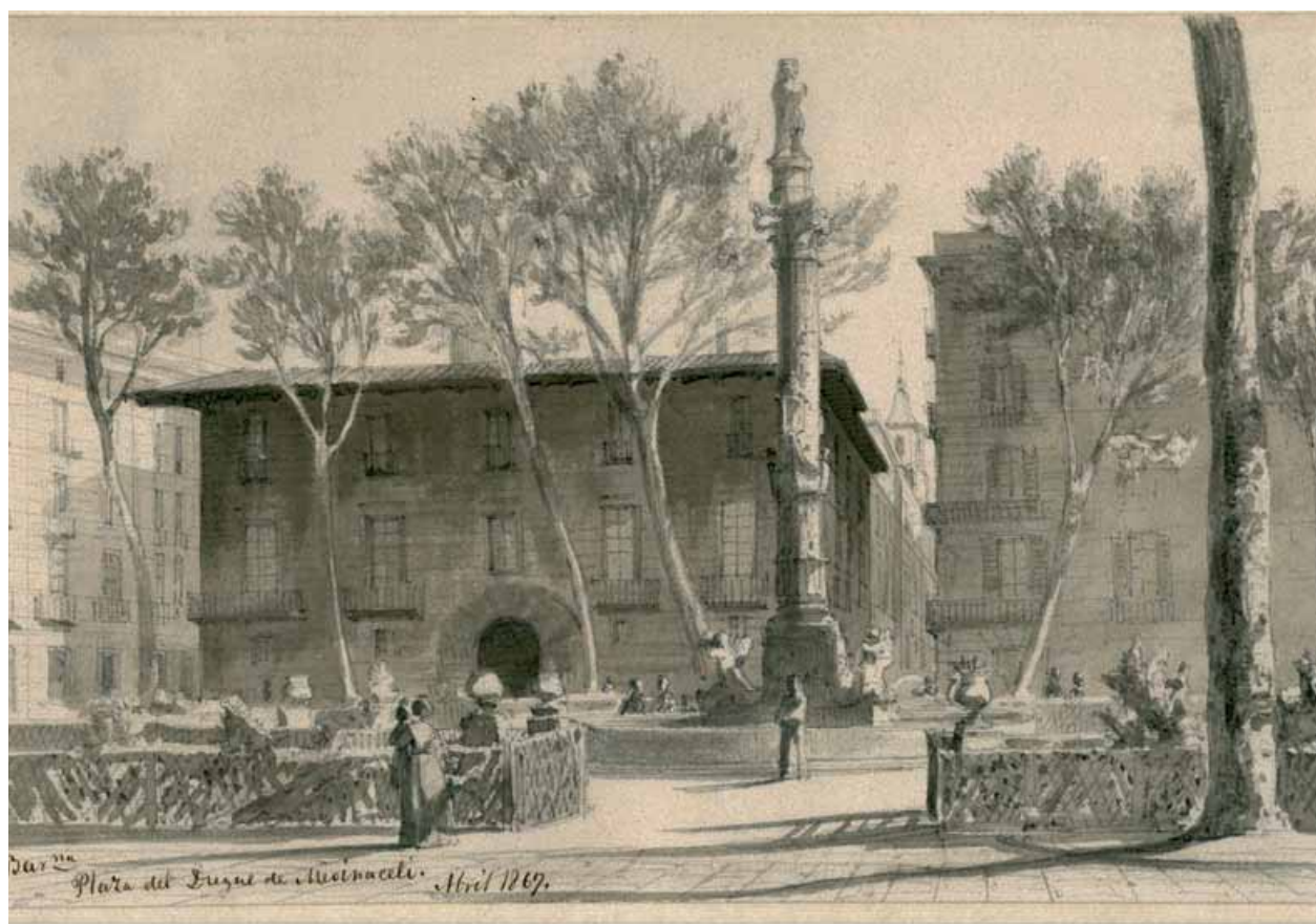
La font de Galceran Marquet de F. Daniel i Molina, instal·lada el 1851 a la plaça del Duc de Medinaceli, allotjava a 7,70 m d'altura un repartidor que podia servir 21 cases.
