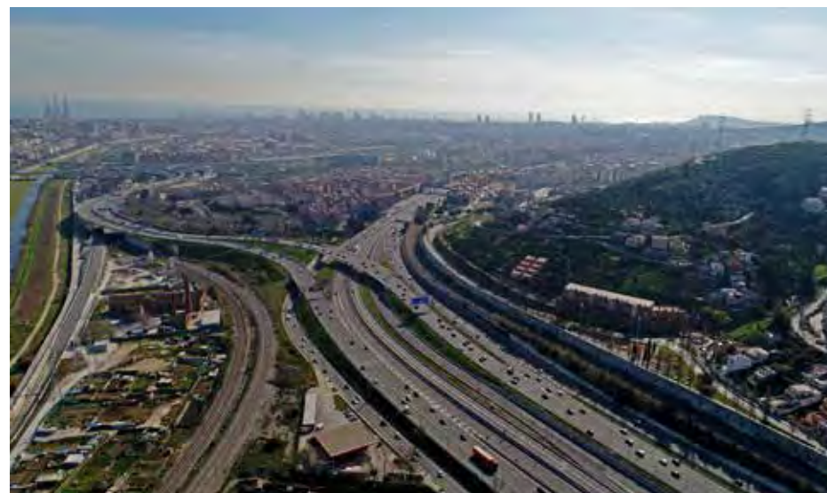
Vista aèria de les infraestructures que separen Vallbona de Torre Baró i Ciutat Meridiana Font: Ajuntament de Barcelona
