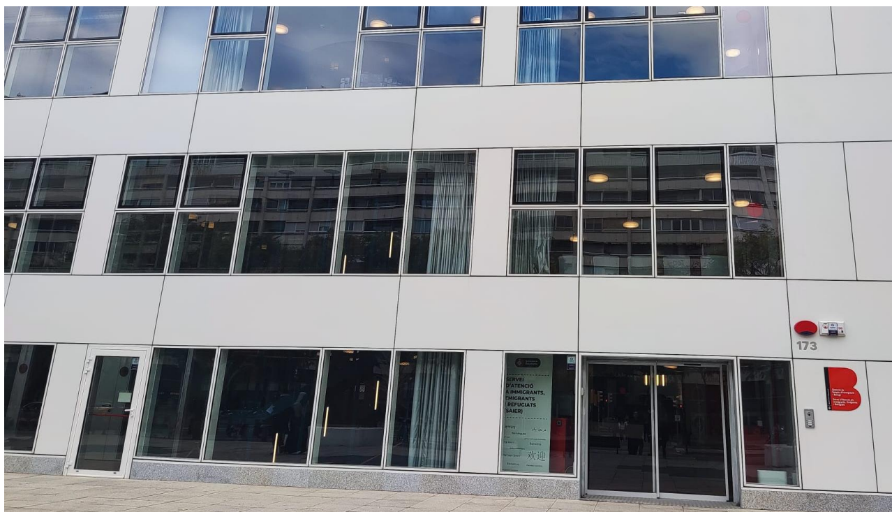
Il·lustració 4. Fotografia de la façana de la nova seu del SAIER al carrer Tarragona, 173
