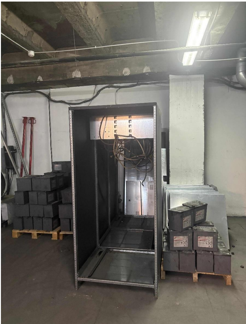
ADEQUACIONS SALES TÈCNIQUES
