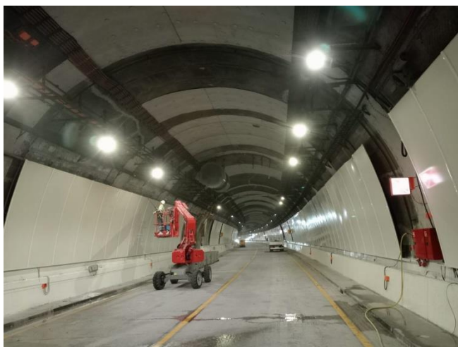
COL·LOCACIÓ DELS PANELLS VITRICATS
