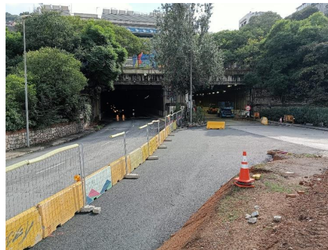
EXECUCIÓ DELS TRANSFERS A LES BOQUES
