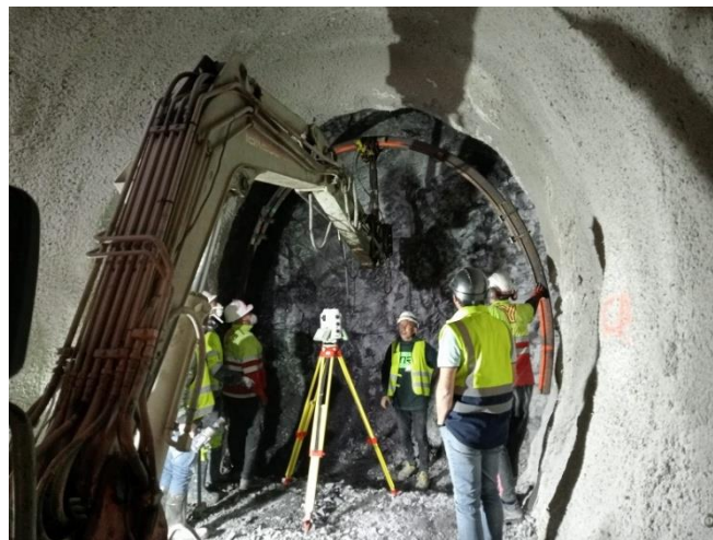
EXECUCIÓ DE GALERIES D'EVACUACIÓ
