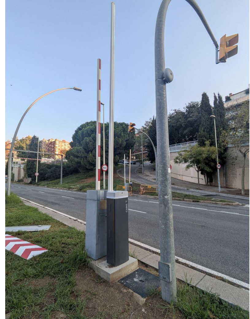
RENOVACIÓ DELS ELEMENTS DE CONTROL A L'ENTRADA DEL TÚNEL
