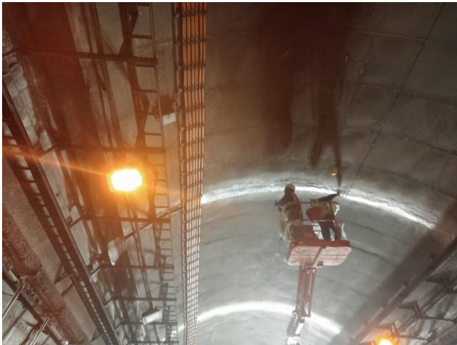
REPARACIÓ DE JUNTA ENTRE VOLTES
