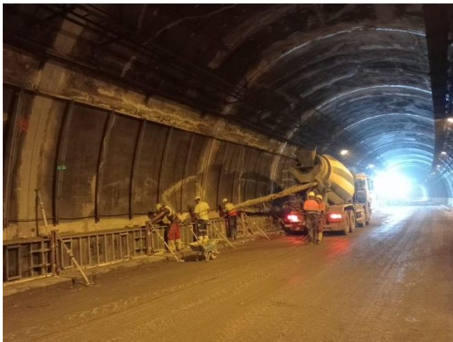
MURETS DE DRENATGE LATERALS
