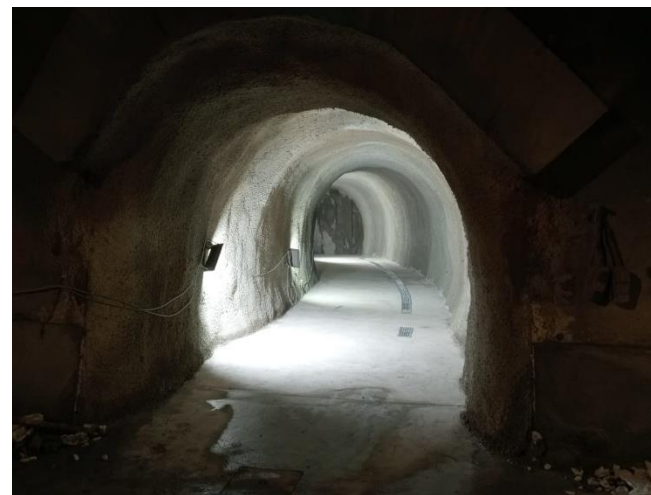
EXECUCIÓ DE GALERIES D'EVACUACIÓ
