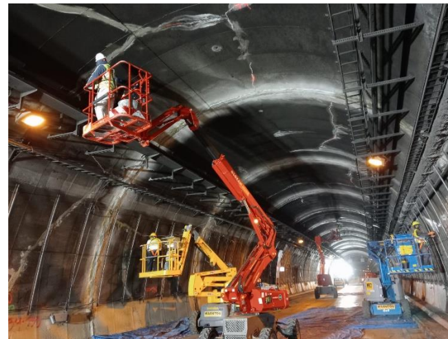
REPARACIÓ DE FISSURES EN VOLTA
