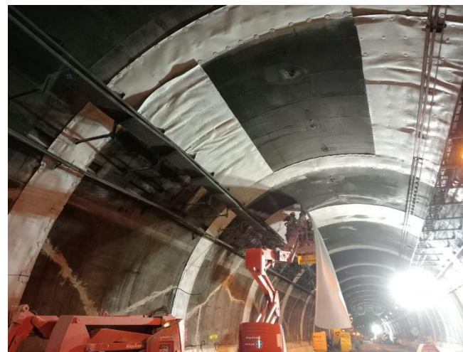
COL·LOCACIÓ DE LÀMINA IMPERMEABLE EN VOLTA
