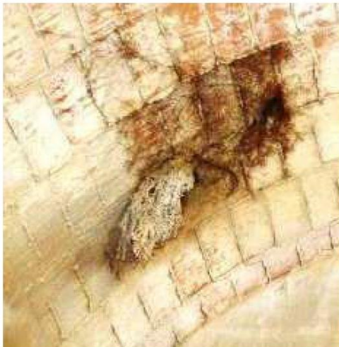
Boca de captació
