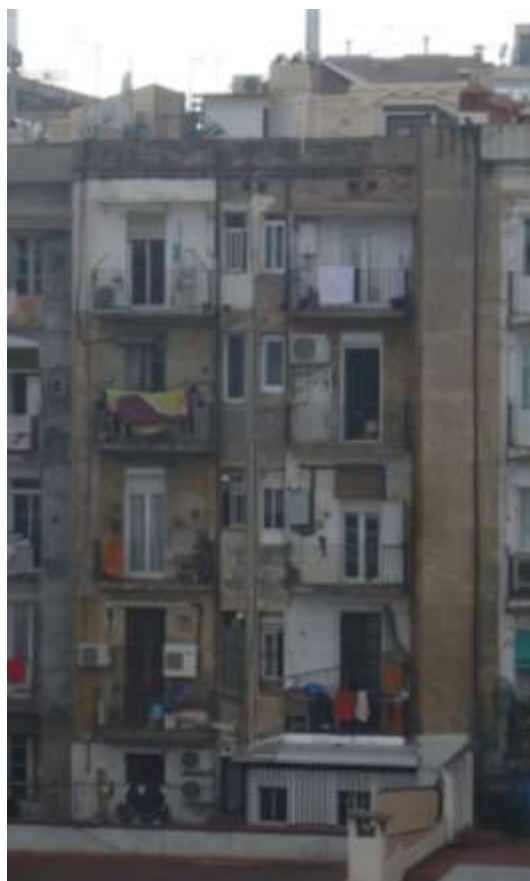
Rehabilitació a Villarroel, 26
