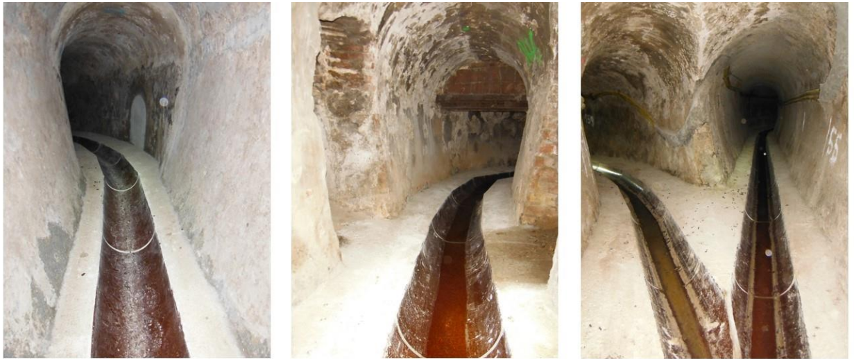
Rehabilitació xarxa de clavegueram (col·locació cubeta de gres) al barri de Sants
