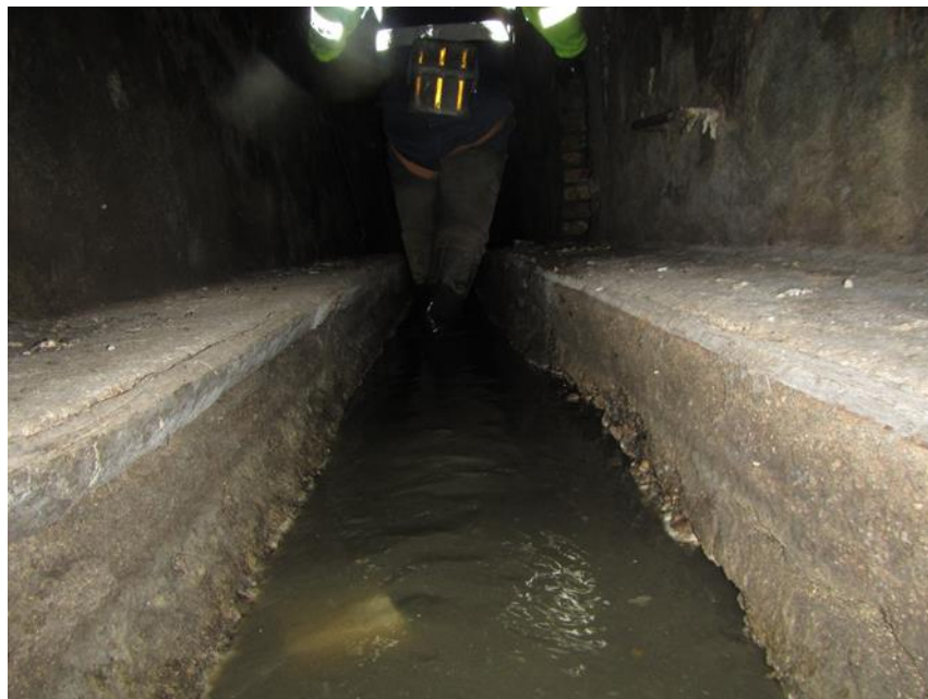
Tram del clavegueram al carrer del Carme previ a la rehabilitació
