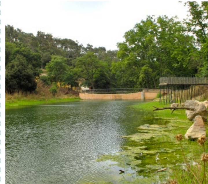
La construcció del pantà a la capelleta de la riera de Vallvidrera, 1850-1860, és un ambiciós projecte de l'arquitecte Elies Rogent de captació amb una presa i aprofitament de l'aigua d'escorrentia, que era conduïda a Sarrià a través de la mina de Grot i distribuïda des de la torre del Molí. Foto: Robert Peña Arxius Parac de Collserola [D1]
