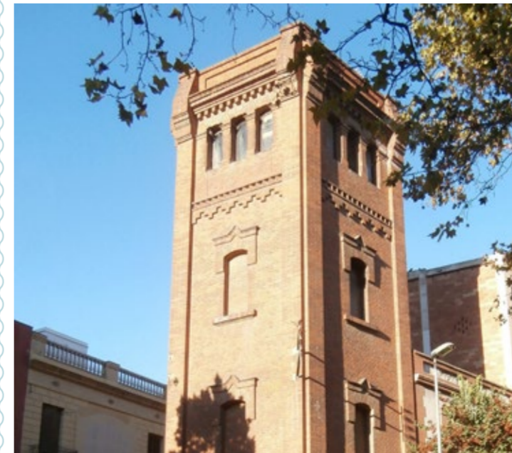
El pilar d'aigua del carrer del Lluanguodoc és una fita urbana i un dels vestigis més eminents del sistema tradicional de provisió d'aigua de boca. Situat emmès de la rambla de Fabra i Puig i construït cap a 1904 per substituir l'original de 1869, feia de repartidor general de la mina de Santa Eulàlia. Foto: Jordi Sánchez [R6]
