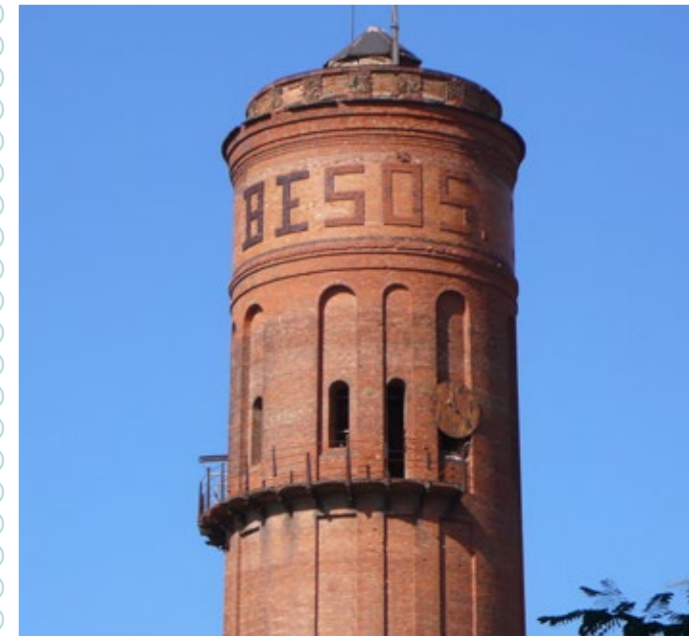
Van ser molt nombrosos els pous i les elevacions al barri del Poblenou. Hi ha molts de documents, però actualment en queden molt pocs de visibles. La Torre de les Aigües del Besòs, inaugurada el 1882 per proveir d'aigua de boca la ciutat, n'és el vestigi més destacat i més monumental. Foto: Ignasi Mangue [T3]
