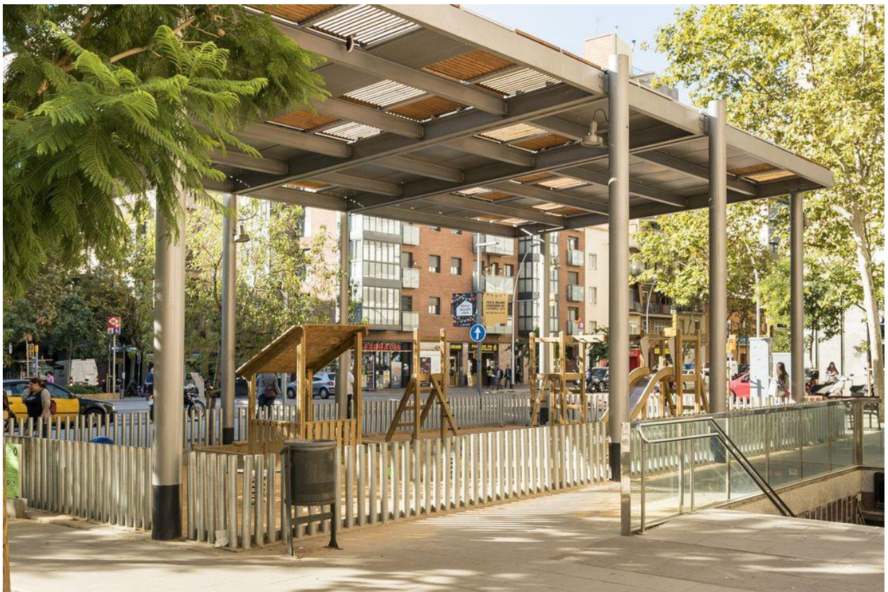
Pèrgola solar a la plaça del Centre
