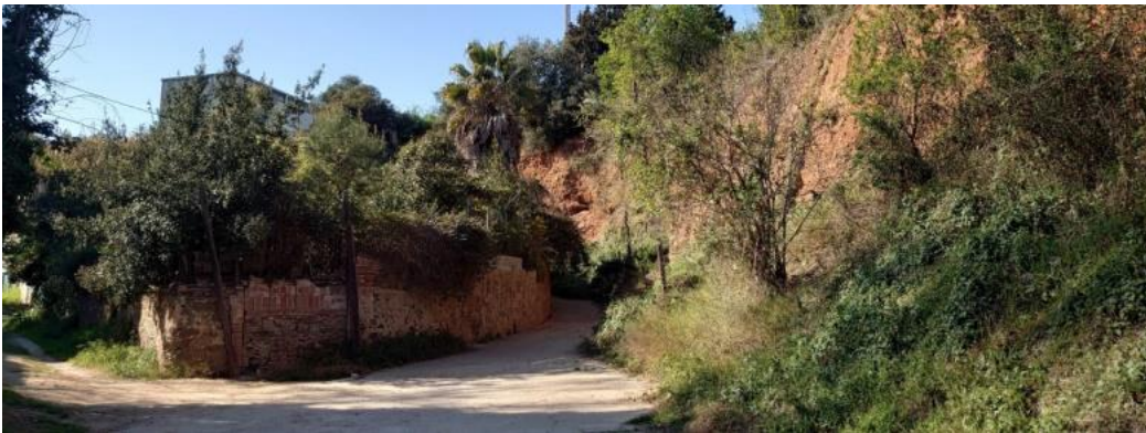
Detall dels talussos sobre el camí històric de Sant Cebrià
