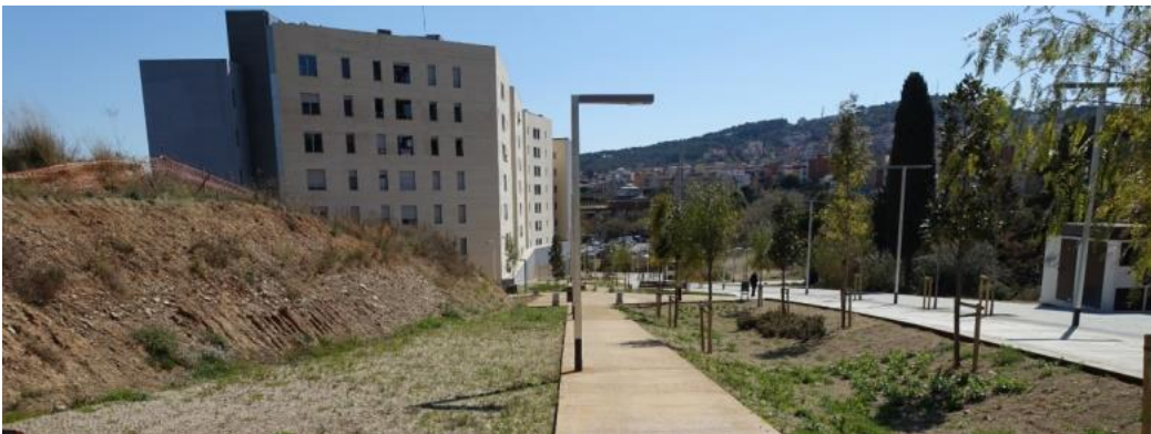
Tram de vial urbanitzat
