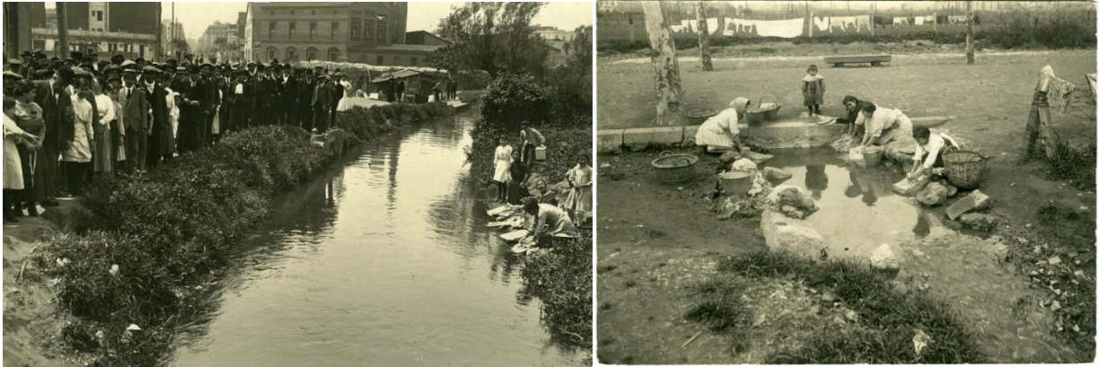
Inauguració de les obres de desviament del Rec Comtal, al 1916 (esq.) i el rec a la plaça de les Glòries, prop dels Encants, al 1917 (dreta). Autor: Frederic Balell / Arxiu fotogràfic de Barcelona
