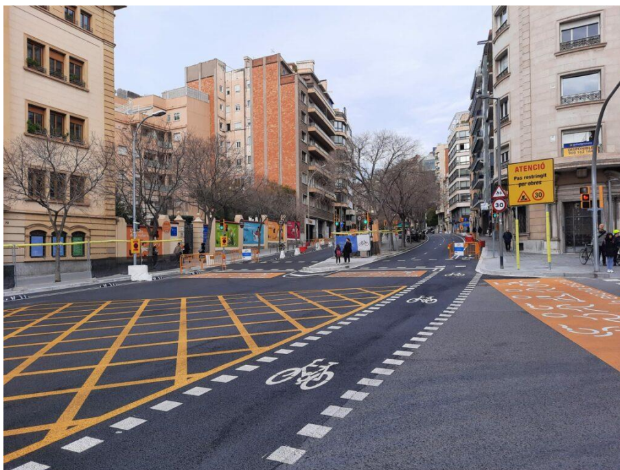
Fig. 1: Obres d'execució del carril tram Laforja–Ganduxer ; Font: ajuntament.barcelona.cat
