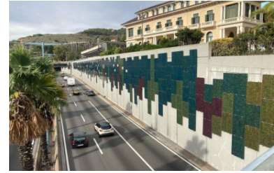
Instal·lació solar Ronda de Dalt
