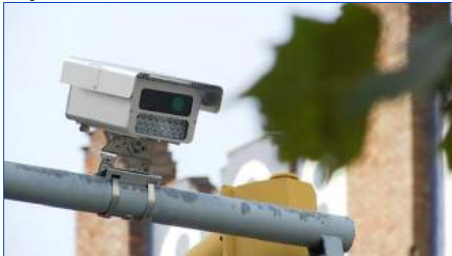
Imatge 13. Càmera de la ZBE instal·lada a Barcelona.
