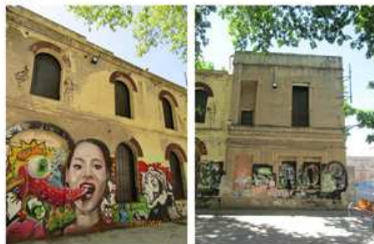
Façana nord edifici B
