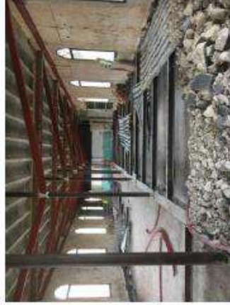
forjat pl. 3a en fase d'enderroc
